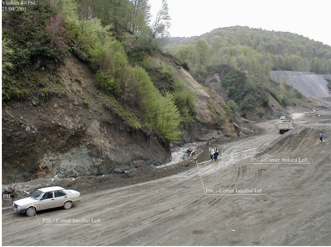
Şekil A.5 Anadolu Otoyolu V4 Viyadüğü P6L Temel Kazısının Yeri.
