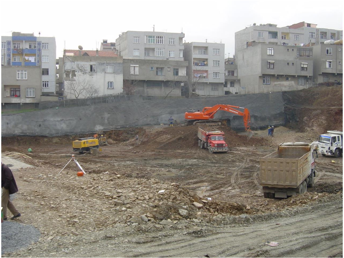
Şekil A.4 Kazı Yapımı ve Kazı Yüzeyinin Düzenlenmesi.
