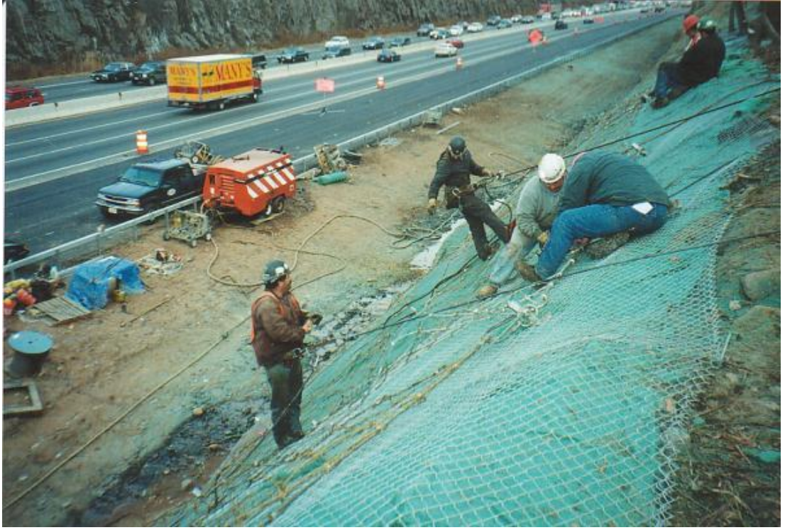
Şekil A.9 Zemin Çivili Duvar Yüzeyine Geotekstil Serilmesi.
