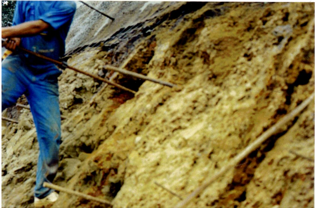
Şekil A.2 Donatının Zemine Yerleştirilmesi.
