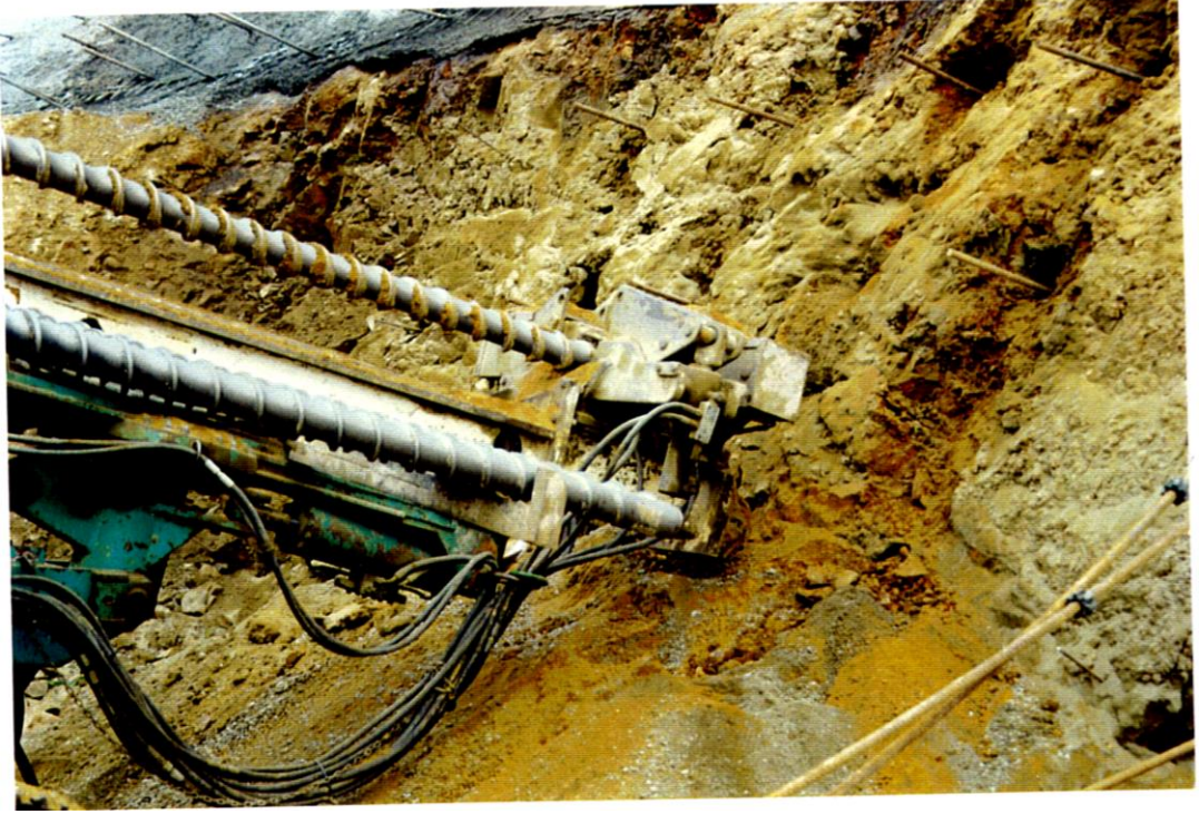
Şekil A.1 Zemin Çivisi Tesis İçin Delgi Yapılması.
