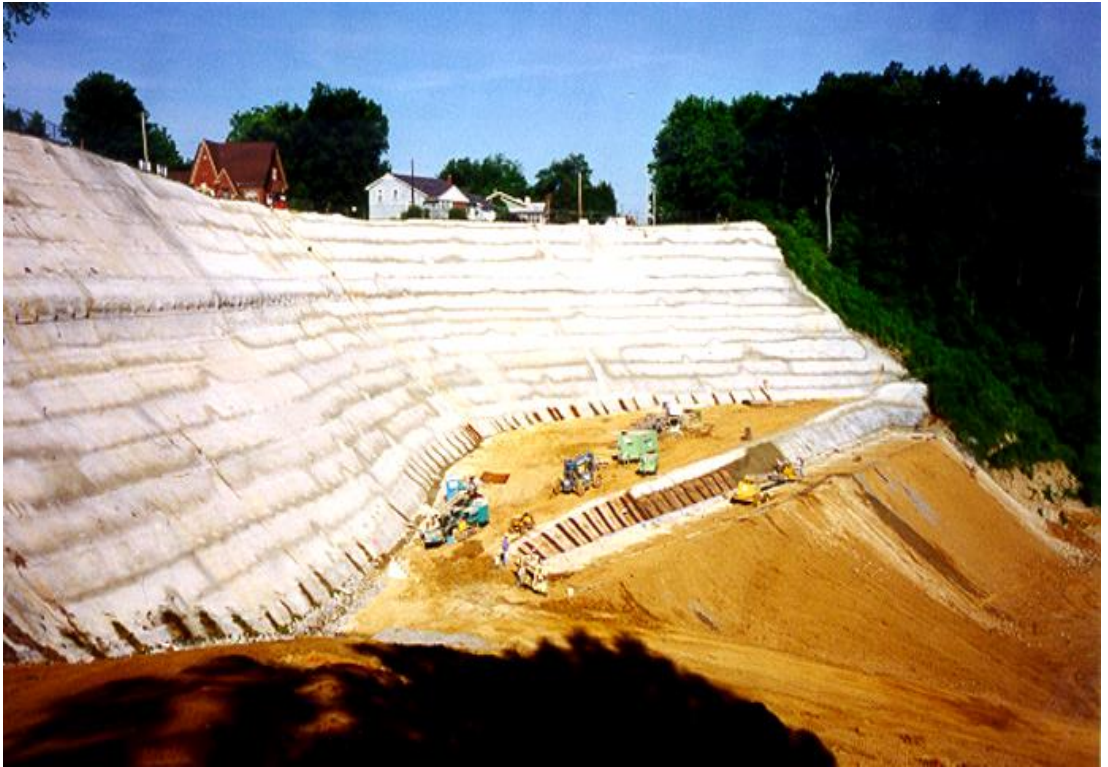
Şekil A.8 Kademeli Zemin Çivili Duvar İnşaatı.
