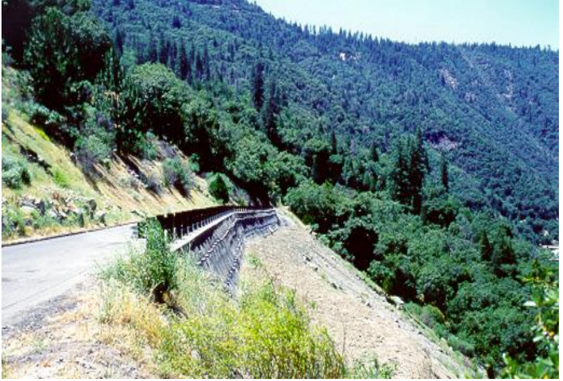
Şekil A.7 Zemin Çivileriyle Yol Şevi Stabilizasyonunun Sağlanması.
