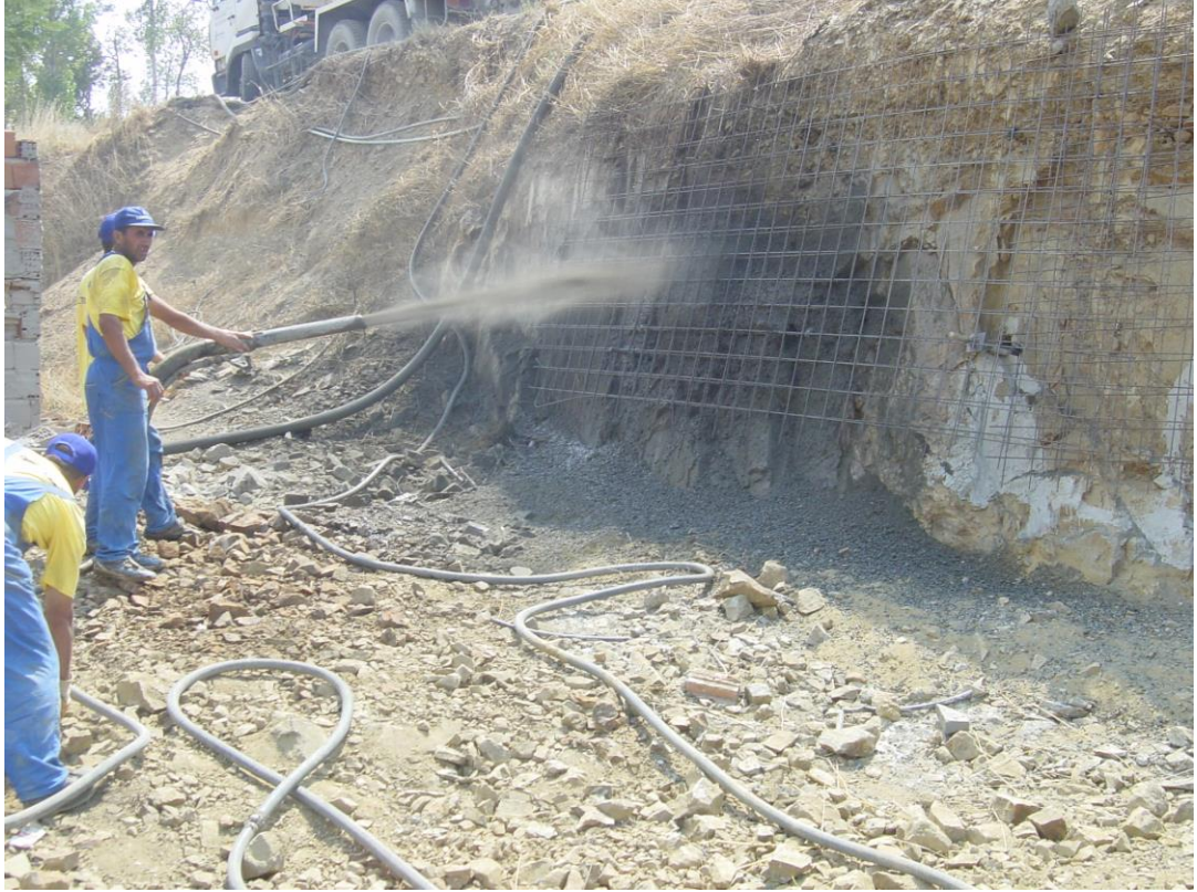
Şekil A.3 Püskürtme Betonun Uygulanması ve Kaplama Donatısının Görünüşü.
