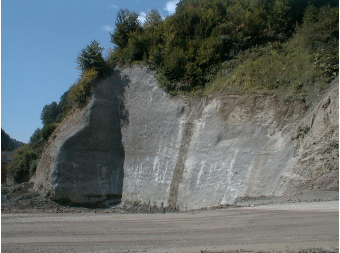
Şekil A.6 Anadolu Otoyolu V4 Viyadüğü P6L Ayağının Zemin Çivisiyle Desteklenmesi.
