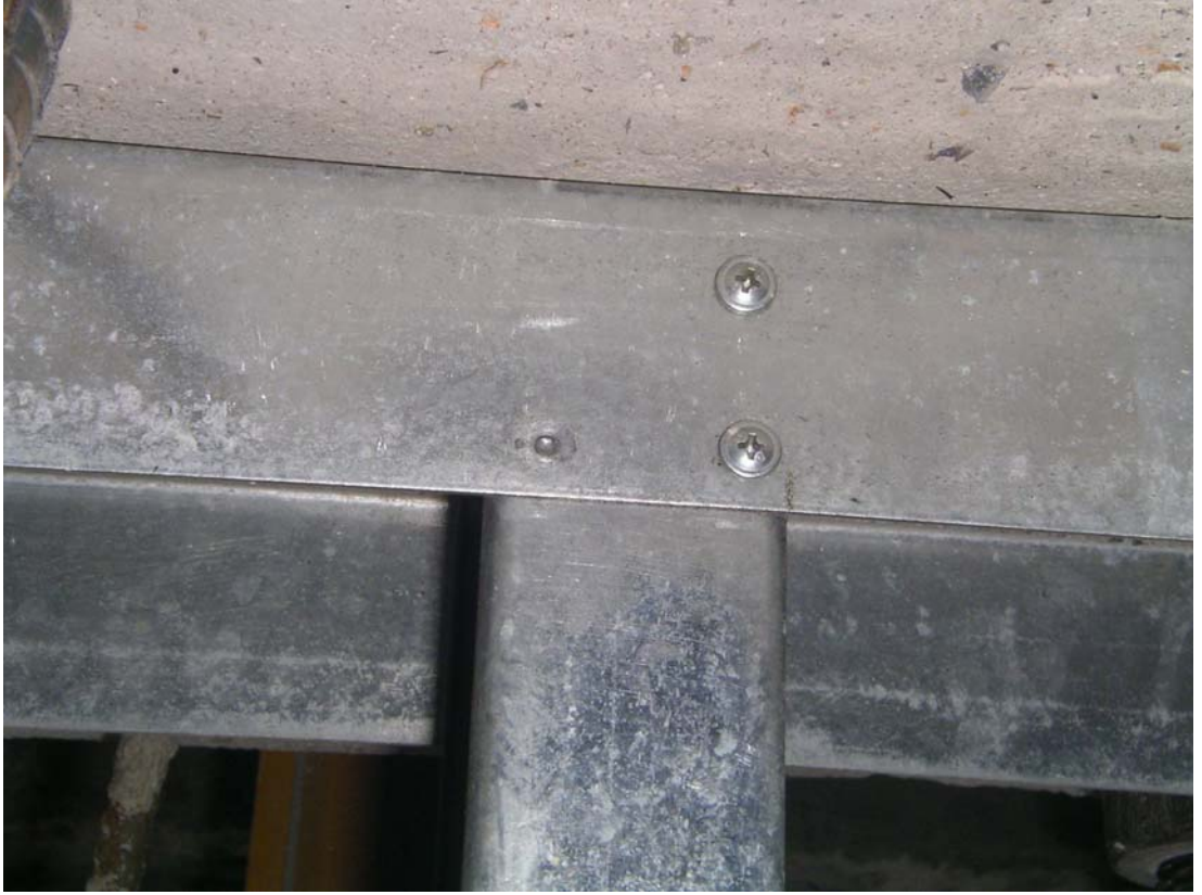
Şekil A.5 Üst Başlık ve 5. Dikme Birleşimindeki Vida Başının Kopması
