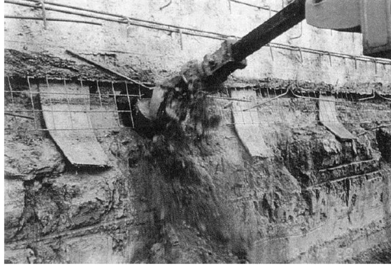
Şekil 2.2 Geçici püskürtme beton kaplamanın altında drenaj şeritleri (Porterfield ve diğ., 1994)
