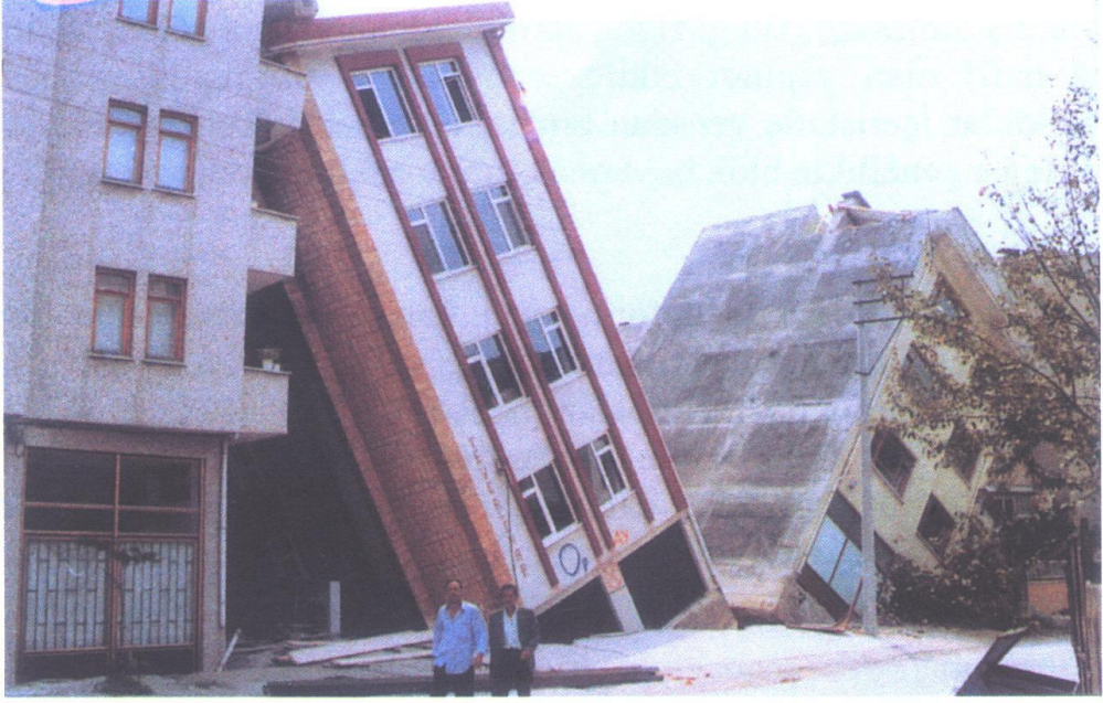
Şekil 3.5. Adapazarı'nda eğilme formunda aşırı temel deformasyonuna maruz kalmış binalar.
