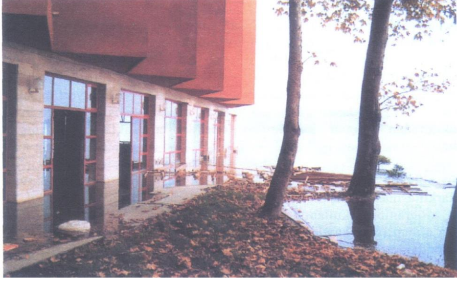
řekil 3.14. Sapanca Gölü'nün doęu sahilinde sıvılařmaya baęlı oturmalar
