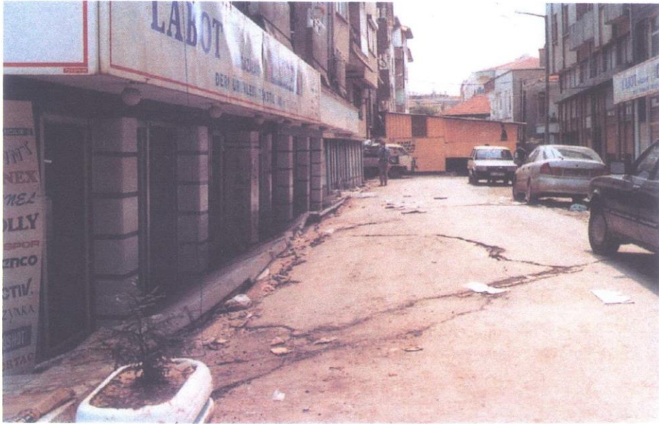
Şekil 3.8. Bitişik nizam bloklarda meydana gelen oturmalar.
