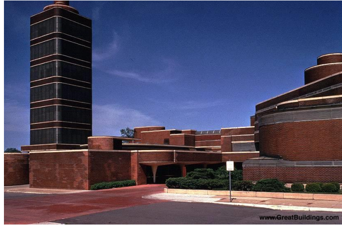
Şekil 4.25 Johnson Wax Administration Center Dış Görünüş, Frank Lloyd Wright.
