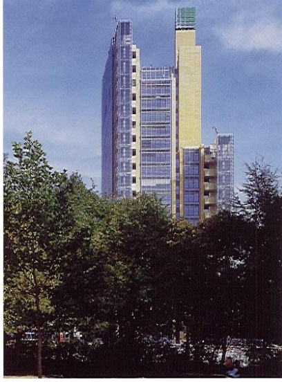
Şekil 3.16. Debi's Binası- Görünüş
