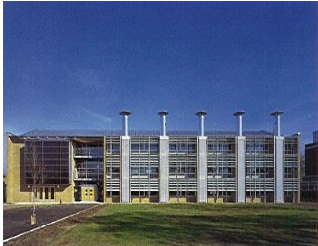
Şekil 3.49. BRE Binası - Görünüş
