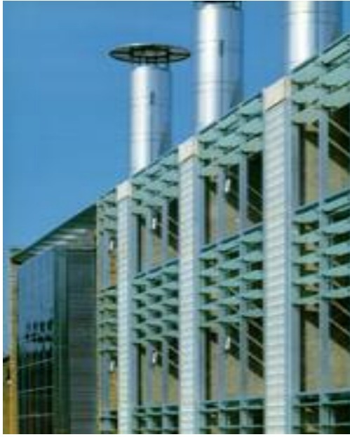
Şekil 3.53. BRE Binası Güney Cephesi Görünümü ( Wgginton, Harris, 2002)
