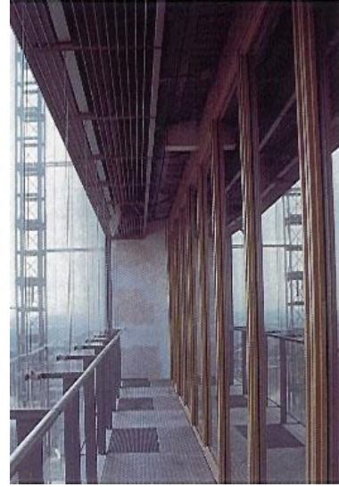
Şekil 3.32. Gty Gate Binası Cephe Kaplama Panelleri Görünüşü
