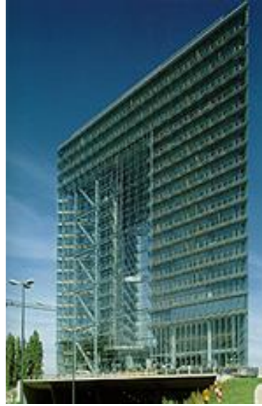
Şekil 3.30. Gty Gate Binası Ön Görünüş ( http://gaialbl.gov/hpbf/ )
