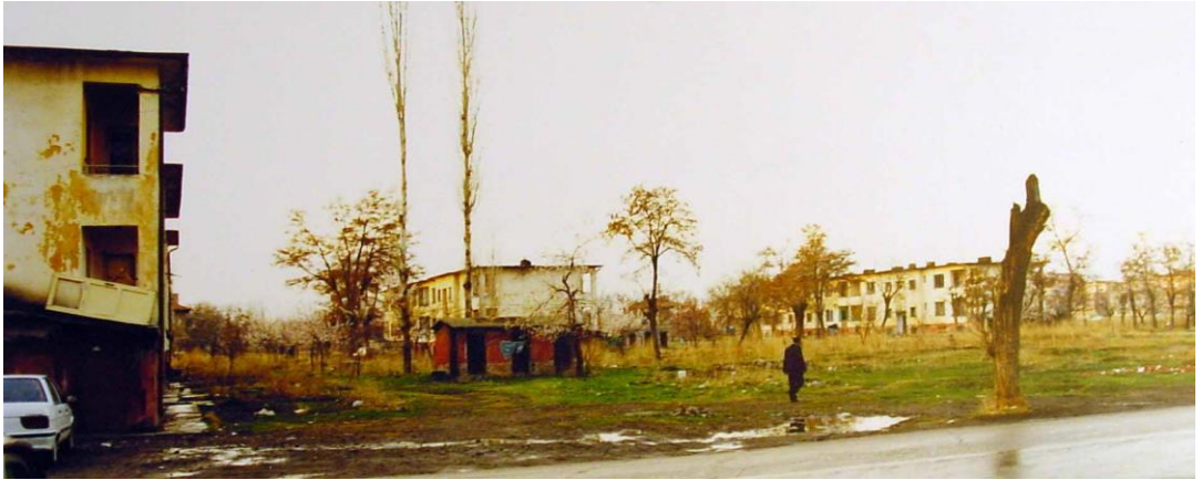
Şekil 6.39. Tıp 3 Dış Usta Emleri Genel Görünüşü
