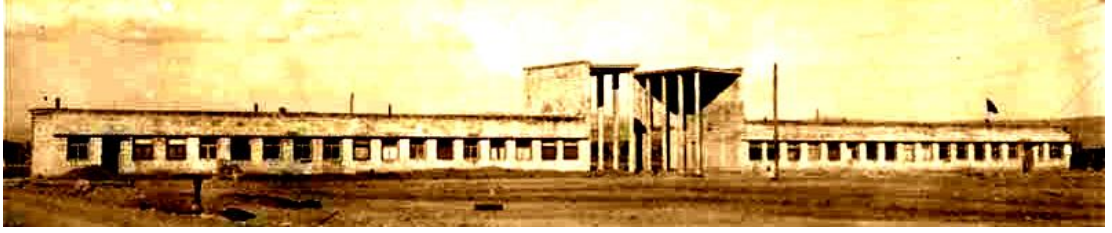
Şekil 6.3 Sümerbank Kayseri Bez Fabrikası Giriş Kapısı, 1935 (Ediş, C)
