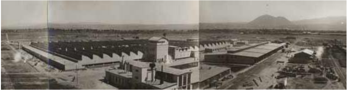
Şekil 6.5 Sumerbank Kayseri Beş Fabrikası İşletme Binaları (Ed ge, Ç 1935)
