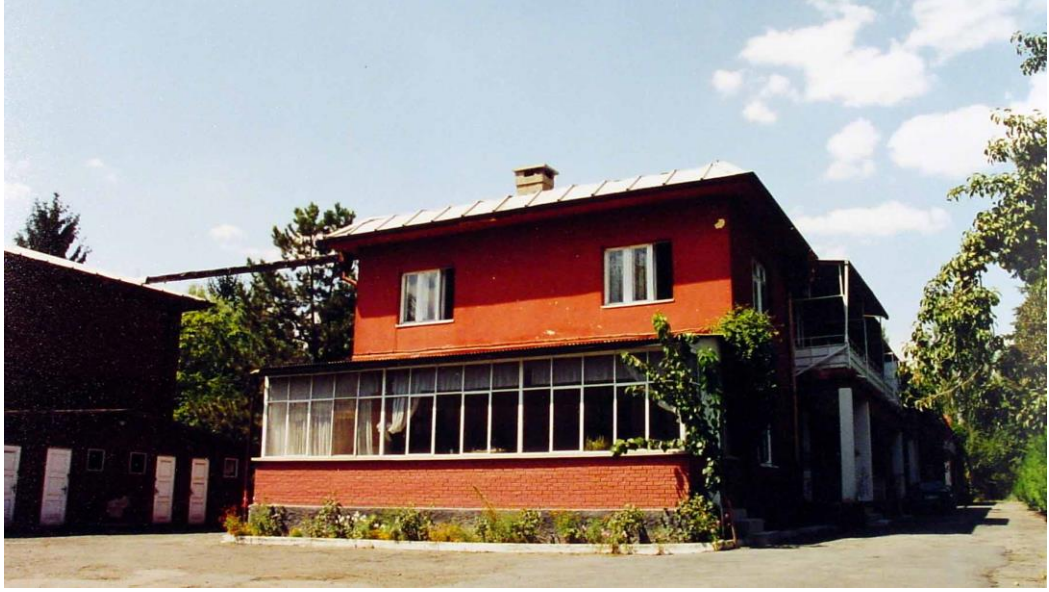
Şekil 6 25. Tıp 1A İç Vazife Evi Giriş Cephesi
