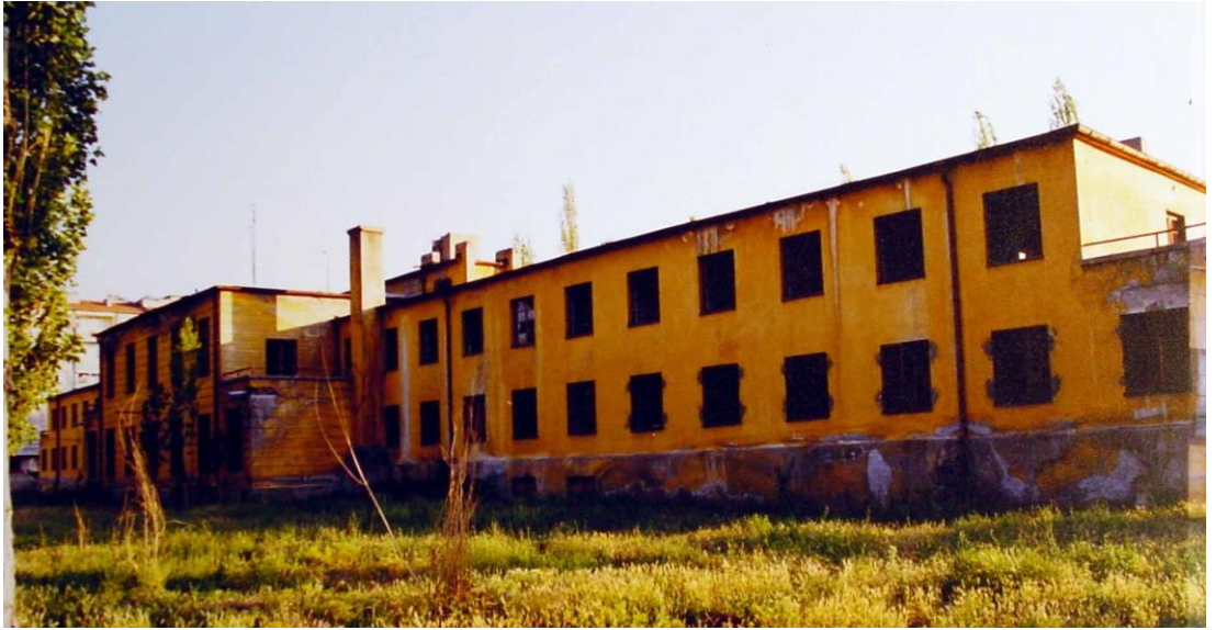
Şekil 6 51. Tıp 5 Bekar Apartmanı Arka Görünüşü
