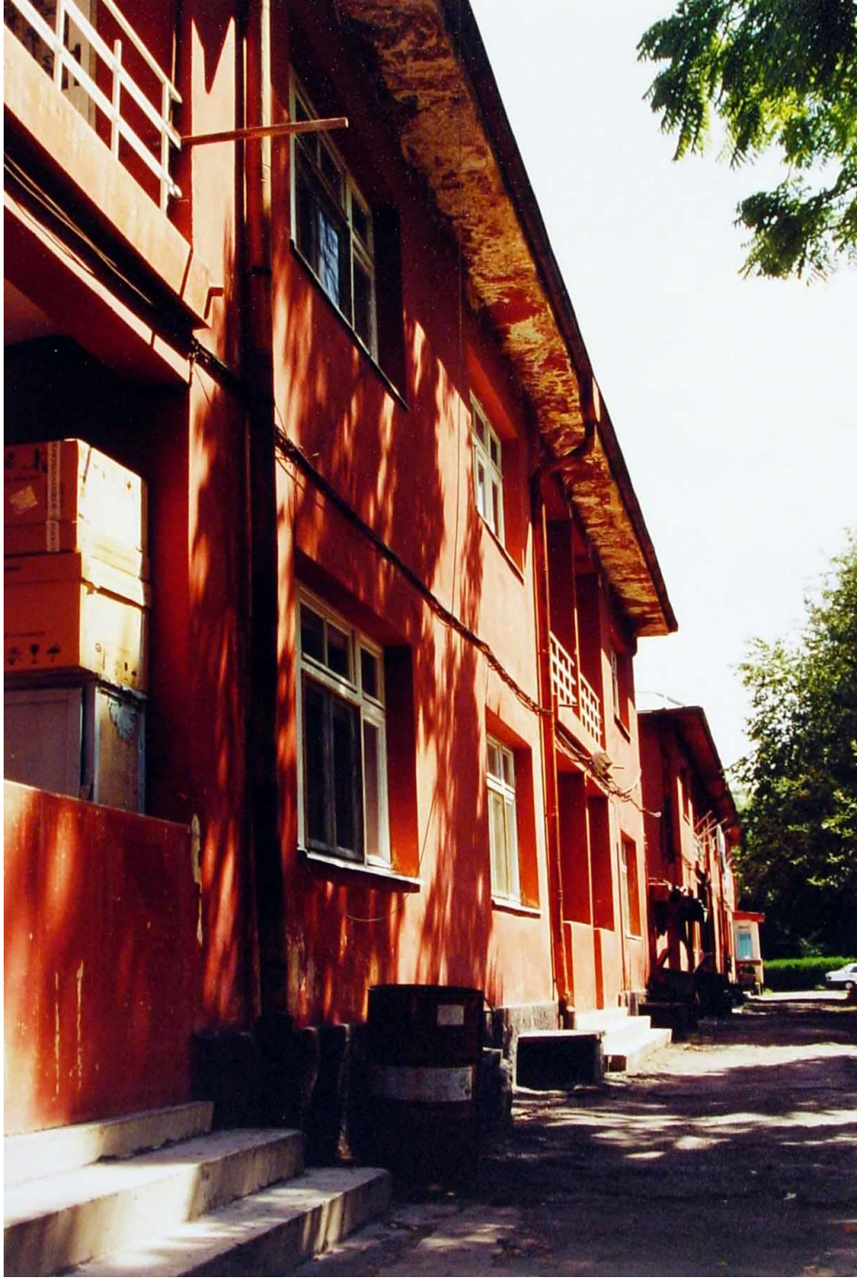
Şekil 6.30. Tıp 1 İç Vazife Evi Arka Cephesi
