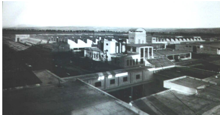
Şekil 6.9 Sümerbank Kayseri Bez Fabrikası İşletme Binaları (Edge, C, 1935)
