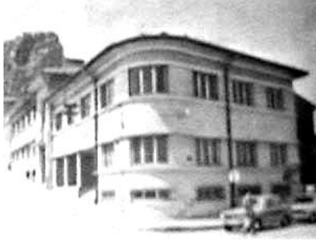
Şekil 5.3 Tekel Binası, Afyon Mimar Tahir Tuğ, 1934 (Aslanoğlu İ., 1979)
