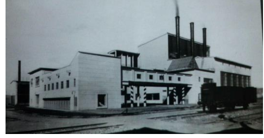
Şekil 6 14 Elektrik Santrali, 1938 (Ediçe, C)
