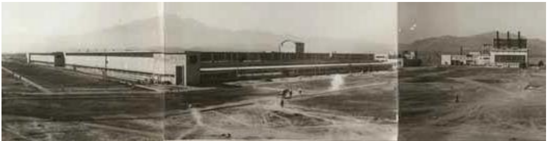
Şekil 6.4 Sümerbank Kayseri Bez Fabrikası İşletme Binaları (Ediş, C, 1935)
