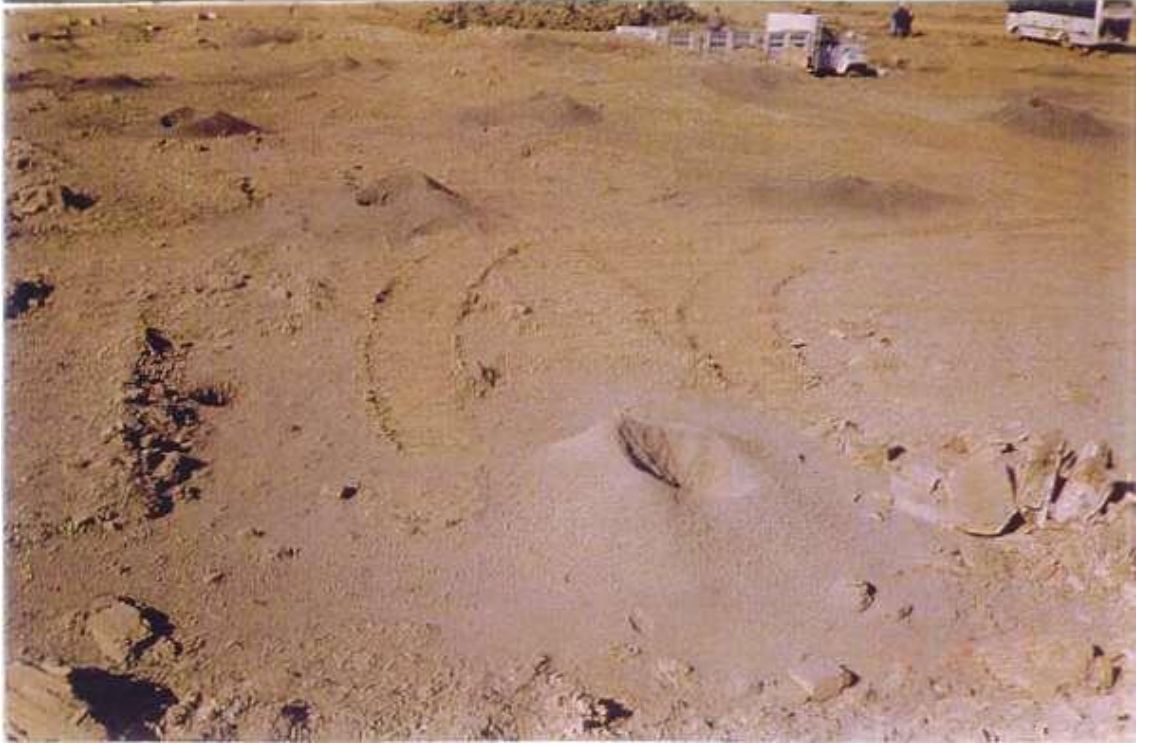
Fotoğraf 4.12 Hatalı Deliklerin Görünüşü
