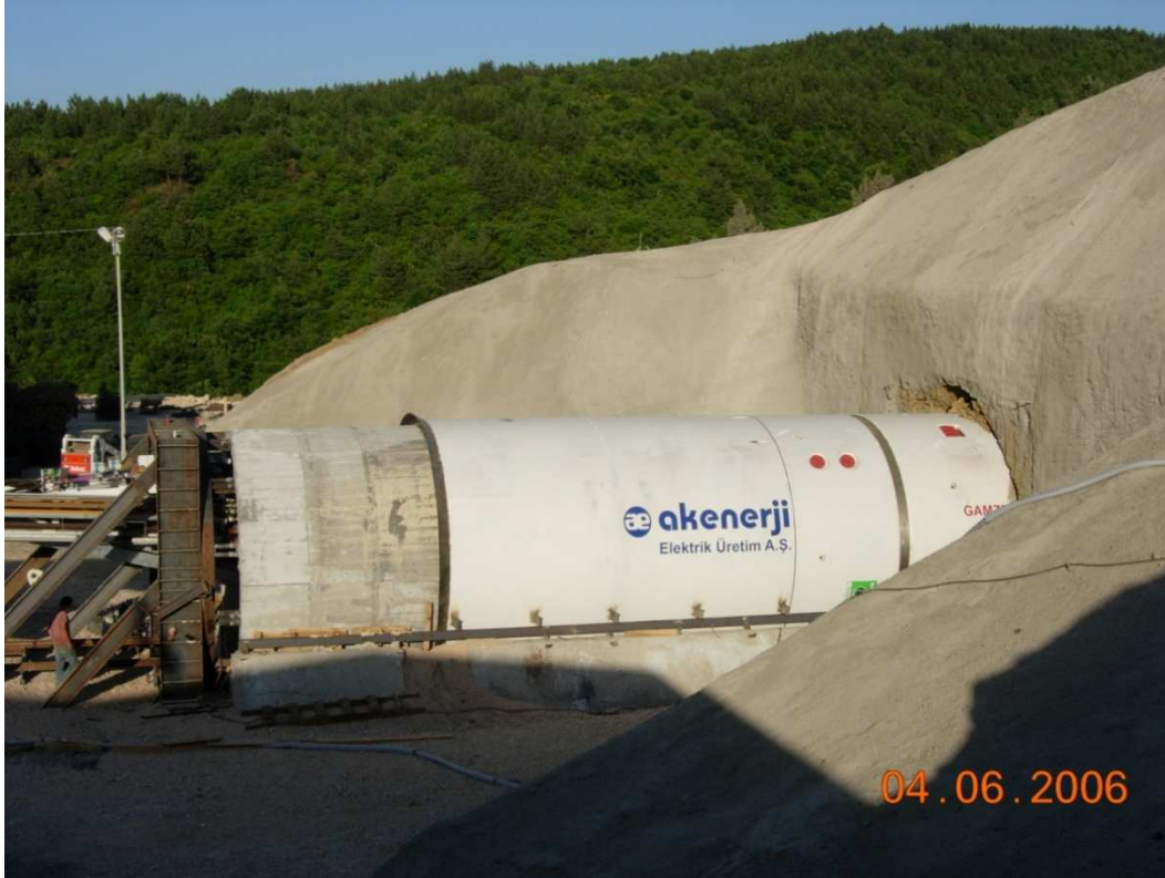
Şekil 3.7. Uluabat Kuvvet Tünelinde Kullanılan EPB TBM.
