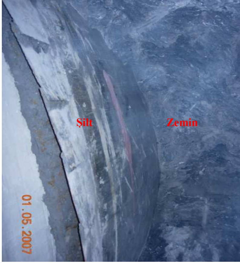
Şekil 6.1. Galeri 3 kazısı sırasında zemin ve şlit görüntüsü
