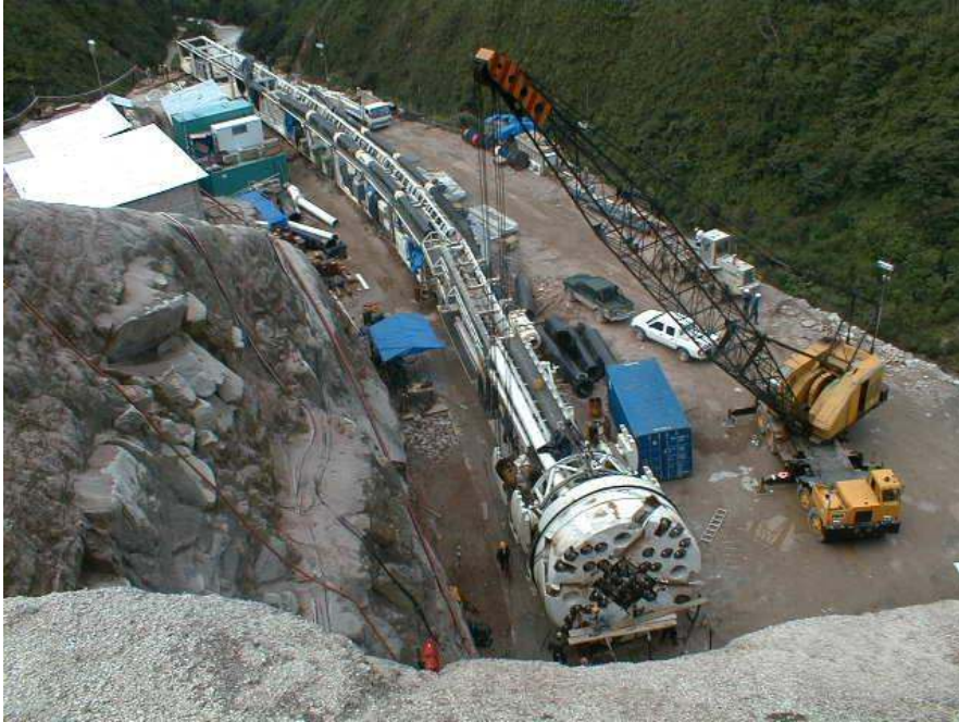
Şekil 2.4: Kaya formasyon kazısı yapan tam cepheli tünel açma makinesi ve yedekleme sistemleri (Herrenknecht).
