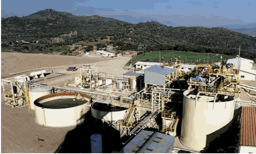
Şekil 3.10 : Bergama-Ovacık tesislerinde kullanılan tank liçi uygulaması [25].
