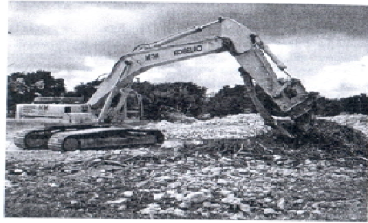
Şekil 3.2 : Vince monte edilmiş kesici (Kiser, 2003).
