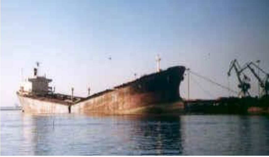
Şekil 5.10 : M/V Lassia hasar durumu.
