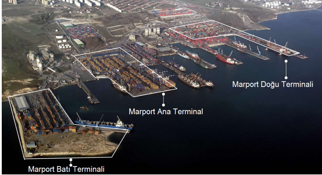
Şekil 3.9: Marport Konteyner Terminalleri
