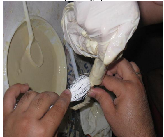
(f) Enjektör ile yapıştırıcının ilavesi
