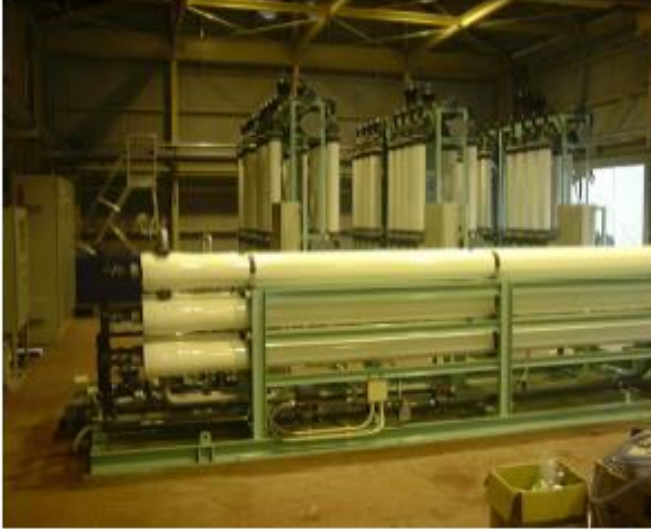
Şekil 4.7: Ters osmoz modülleri arkada nanofiltrasyon modülleri
