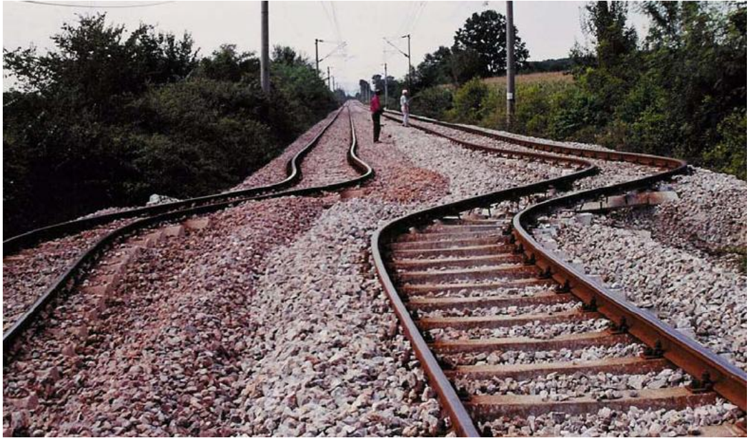
Şekil 4.7 : İzmit'te deprem sonrası demiryolu hattındaki KYD [64].
