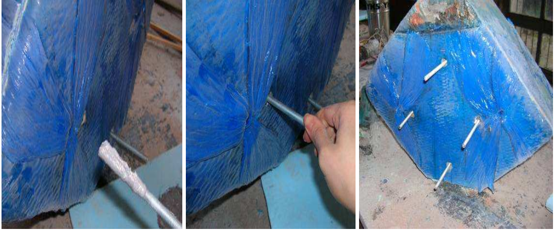
Şekil 4.41: Ölçüm Sistemi İçin Ankraj Uygulaması
