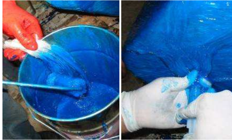
Şekil 4.35: Süreksiz Ankraj Uygulaması için Cam Lifli Kumaşların Hazırlanması
