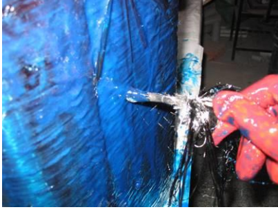
Şekil 4.3.7 Ankrajların Açılan Deliklere Sokulması
