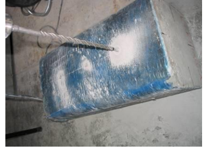
Şekil 4.3.2 Ankraj Deliklerinin Açılması
