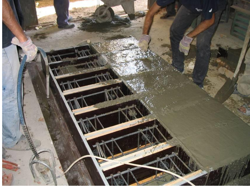
Şekil 3.3.4.1 Kare Enkesitli Numunelerin Beton Dökümü ve Vibrasyon Uygulanması
