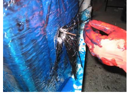
Şekil 4.3.7 Ankrajların Açılan Deliklere Sokulması
