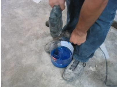
Şekil 4.3.6 Yapıştırıcının Hazırlanması ve Ankraj Yapılacak Yerlere Yapıştırıcının Sürülmesi
