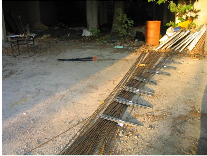
Şekil 3.3.1.3 Boyuna Donatı Çubukları
