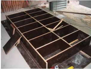
Şekil 3.3.3.1 Kare ve Dikdörtgen Enkesitli Numunelerin Kalıp İmalatı
