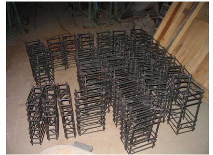
Şekil 3.3.1.5 Donatı İskeletlerinin Hazırlanması
