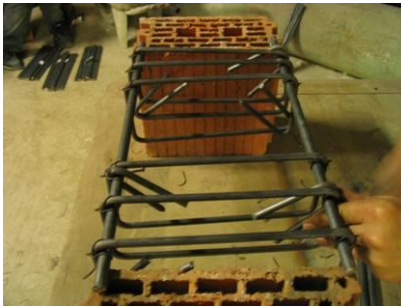
Şekil 3.3.1.5 Donatı İskeletlerinin Hazırlanması
