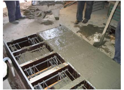
Şekil 3.3.4.2 Silindir ve Kare Enkesitli Numunelerin Beton Döküm Aşamaları
