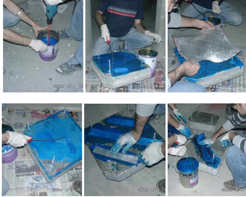
Şekil 2.36: LP Kompozitlerin Yapıştırılması
