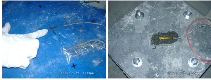
Şekil 4.8: Güçlendirilmiş Elemanlarının Yüzeyindeki Şekildeğiştirmeölçerler
