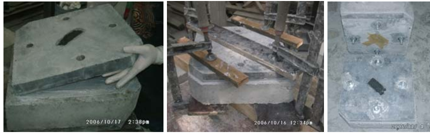
Şekil 1.2: Öndöküm HPFRCC Paneller İle Güçlendirme Uygulaması
