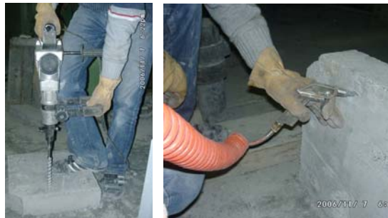
Şekil 2.31: Ankraj Deliklerinin Açılması ve Temizlenmesi
