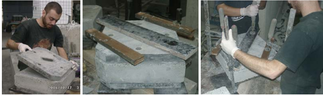
Şekil 2.30: Güçlendirme Panellerinin Yapıştırılması
