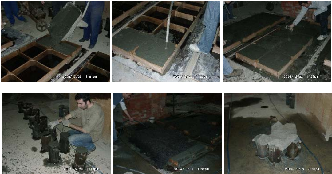
Şekil 2.2: Beton Dökümü ve Kür
