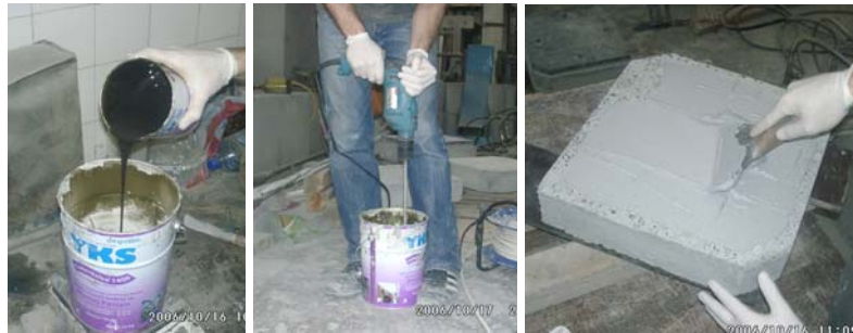
Şekil 2.29: Güçlendirilecek Elemanların Yüzeylerine Epoksi Harcı Uygulanması
