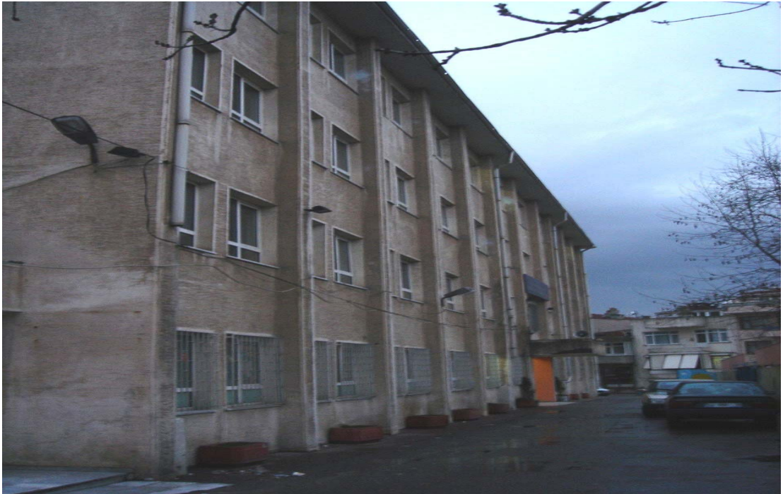
Şekil 7.1: Yapının Dıştan Görünüşü
