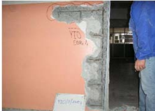
Şekil 7.3: Kolonlarda Uygulanan Paspayı Açma Deneyi
