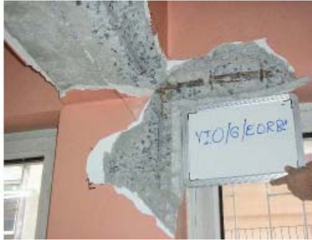
Şekil 7.5: Kiriş ve Kolon Birleşim Noktasına Uygulanan Paspayı Açma Deneyi
