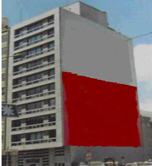
Şekil 5.1: Ön cepheden görünüş
