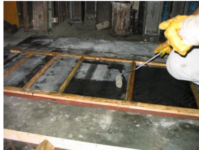
Şekil 2.7 HPFRCC Panellerin Kalıpları
