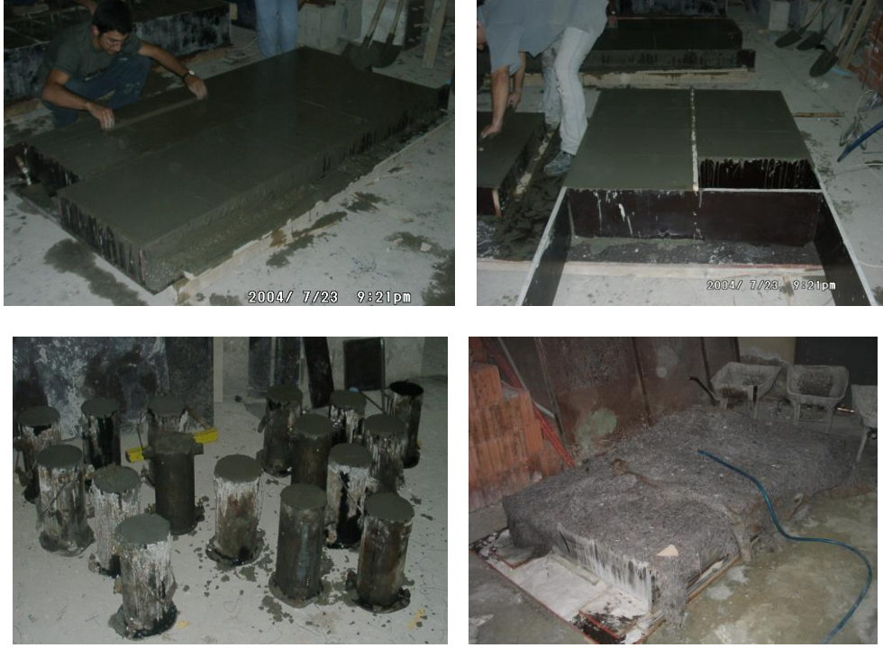
Şekil 2.2 Beton Dökümü ve Kür
