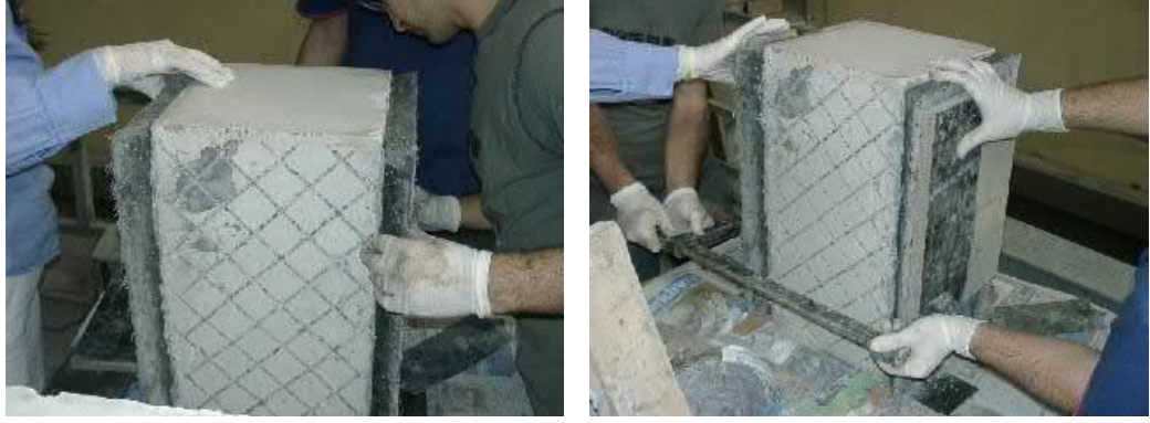
Şekil 2.12 Güçlendirme Panellerinin Yapıştırılması
