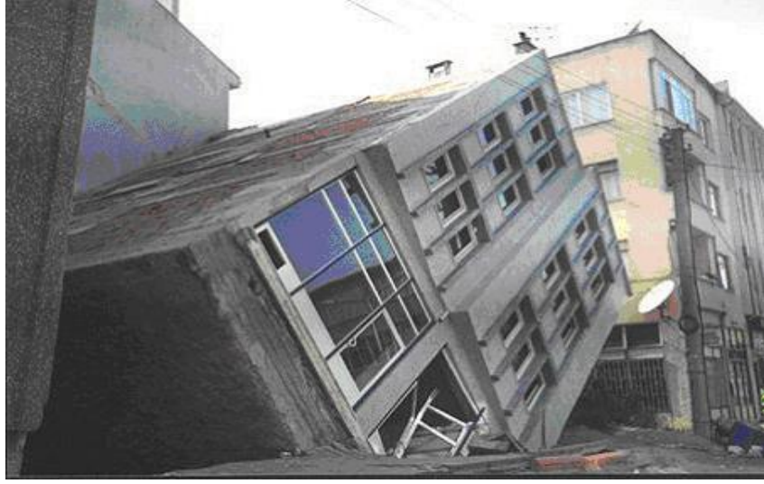
Şekil 2.11 Adapazarı şehir merkezinde sıvılaşmadan dolayı devrilen bir bina
