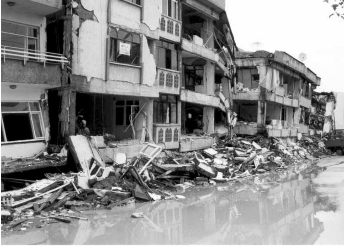
Şekil 2.15 Zemin katlardaki yumuşak kat etkilerinden kaynaklanan hasarlar
