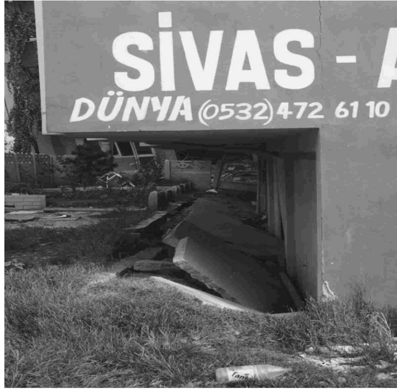
Şekil 2.12 Adapazarı şehir merkezinde 4 katlı binada meydana gelen zemin oturmaları ( 0.8 m oturma meydana gelmiştir )
