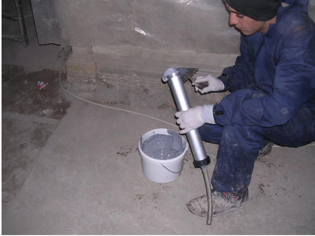
Enejsiyon aletinin içine reçine doldurulur.
