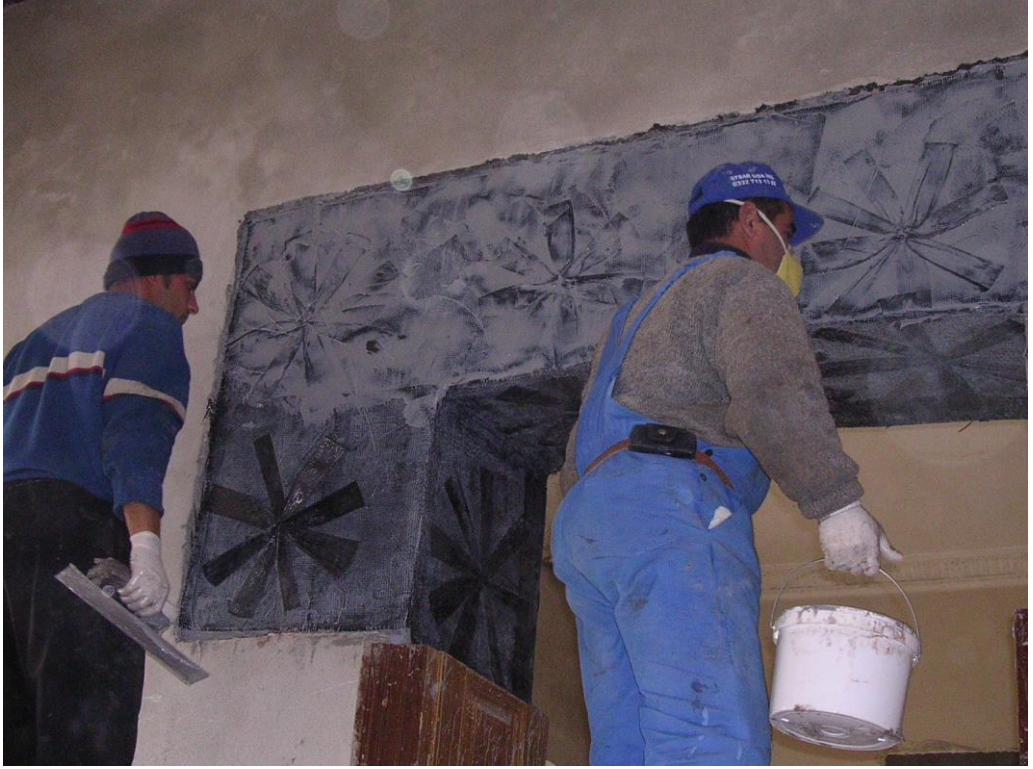
Bütün ankrajlar tamamladıktan sonra yüzeye son kat solvent sürülür.
