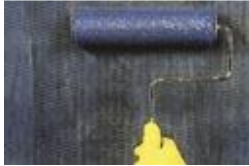
Şekil 5.29 Reçinenin yüzeye sürülmesi
