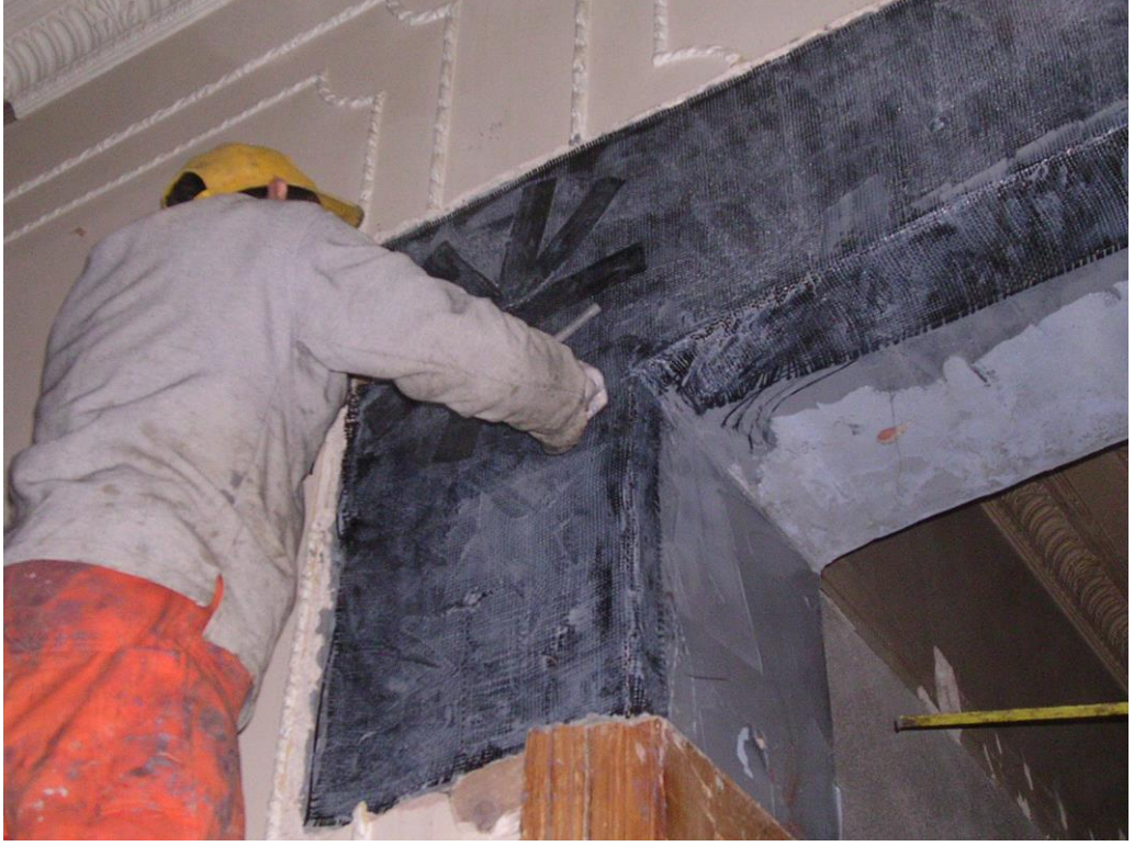
Parçalar halinde açılmış FRP, yüzeye yapıştırılarak ankraj tamamlanmış olur.
