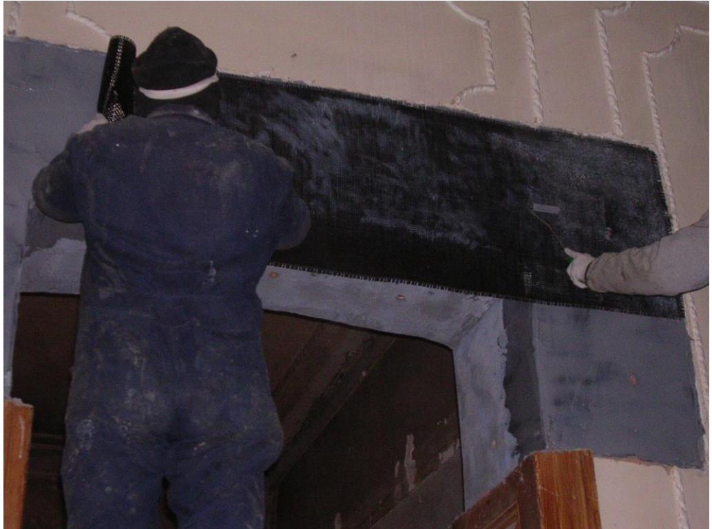
Levhalar reçine sürülen yerlere yapıştırılır.
