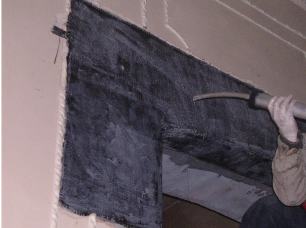
Önceden açılmış deliklerin içine reçine enjekte edilir.
