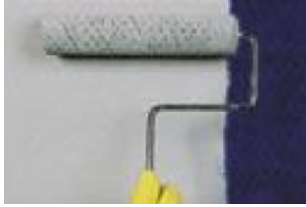
Şekil 5.31 FRP'li yüzeyin sonlanması
