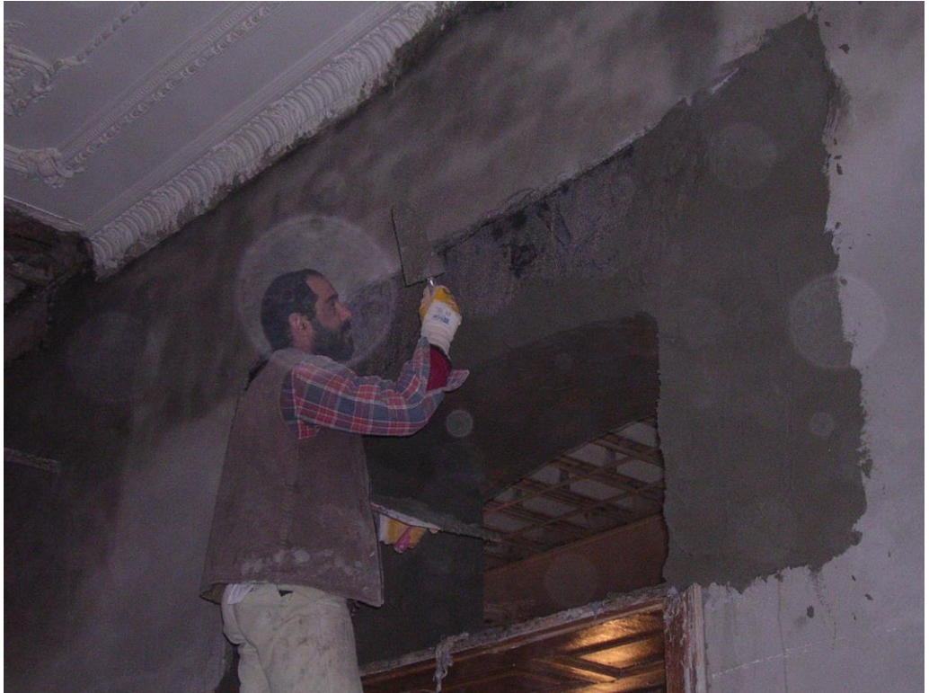
Kumlamadan sonra yüzey sıvanır ve yüzey boyaya hazır hale gelir.
