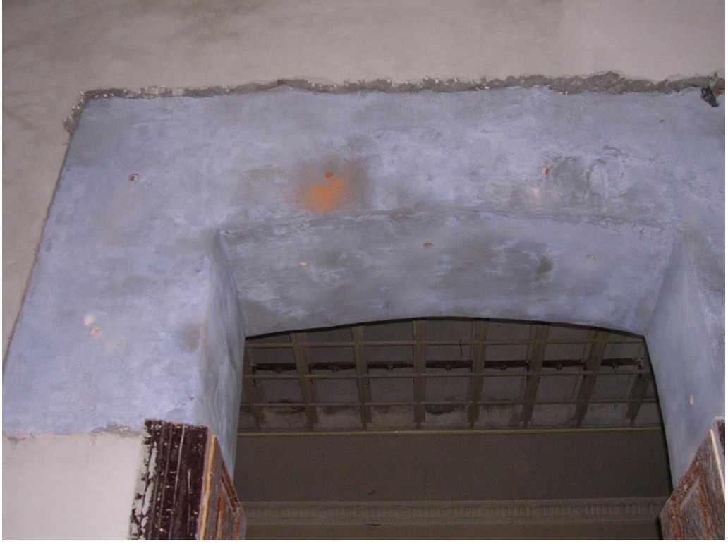
Güçlendirme yapılacak bölgelere dolgu malzemesi sürülerek, projede belirtilmiş yerlere ankraj için delikler açılmıştır.
