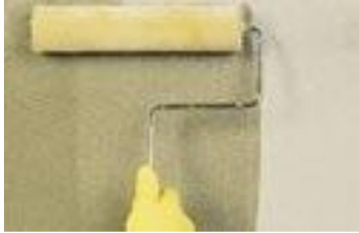
Şekil 5.27 Beton yüzeyin üzerine astar sürülmesi
