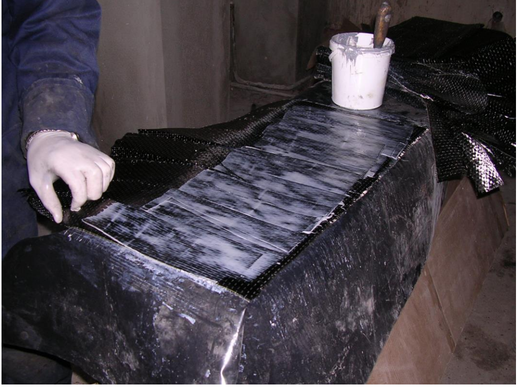
Bu FRP parçaların içine reçine sürülür.
