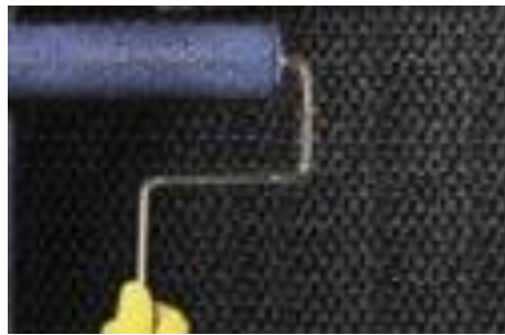
Şekil 5.30 FRP'nin Reçineli yüzeye yapıştırılması
