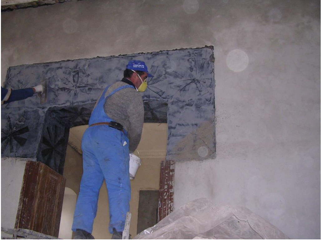
Solvent sürölürken bir yandan da kumlama işlemi başlar.
