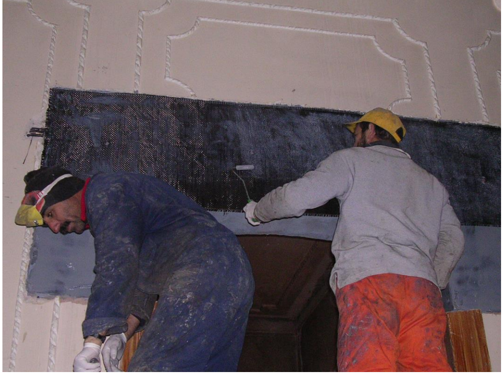
FRP levha üzerine tekrar reçine sürülür.
