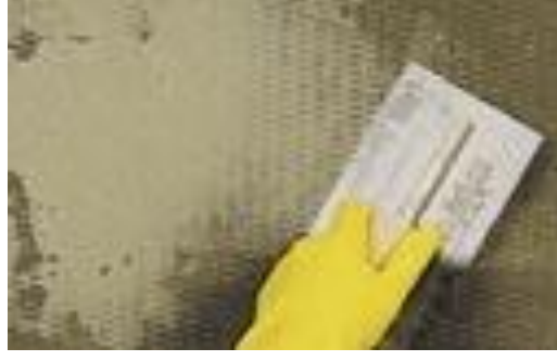
Şekil 5.28 Astarın mala yardımıyla yüzeye yedirilmesi
