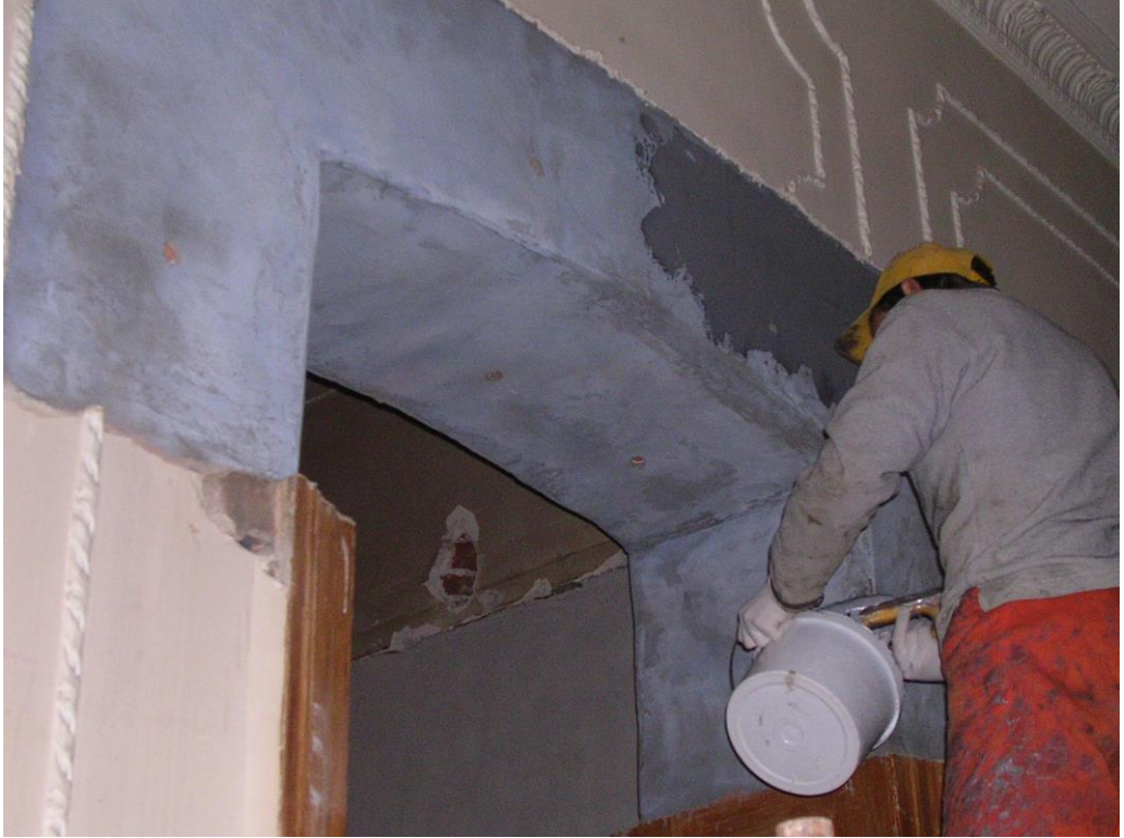
Dolgu malzemesinin üzerine reçine sürülür.
