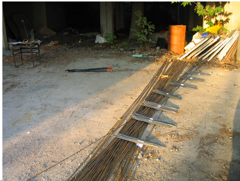
Şekil 2.1 Boyuna Donatıların Kesilmesi
