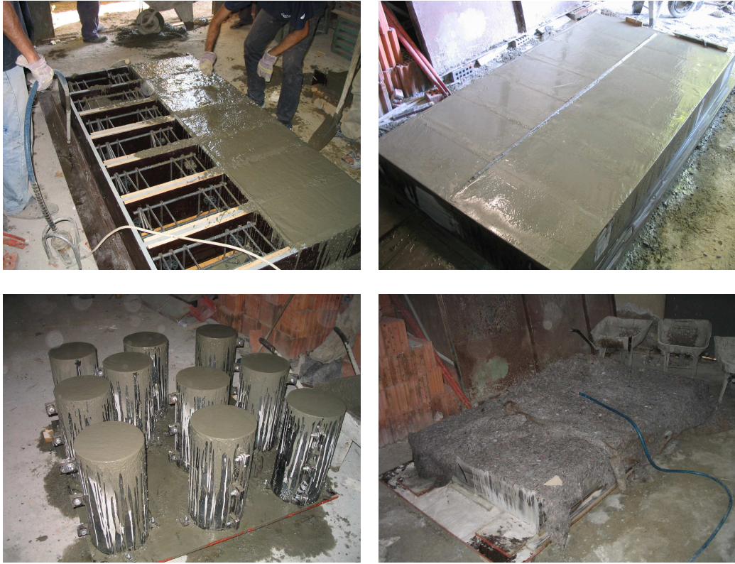
Şekil 2.7 Beton Dökümü ve Kür
