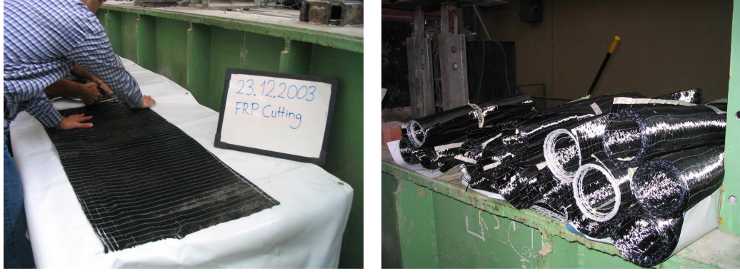
Şekil 4.4 CFRP Tabakaların Uygun Uzunluklarda Kesilmesi
