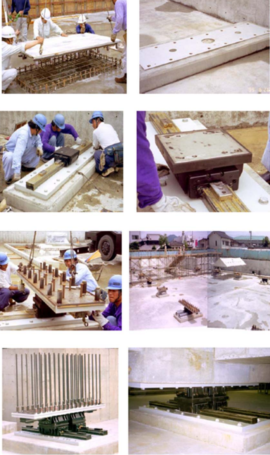
Şekil 3.9 : Çapraz raylı izolatörlerin uygulanma safhaları [12].
