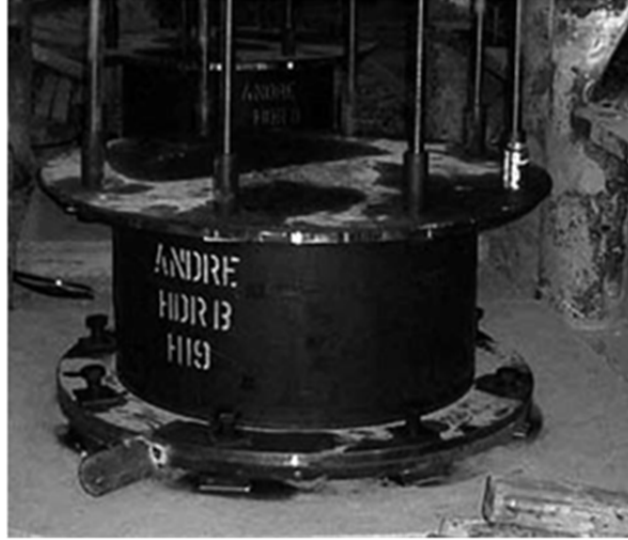
Şekil 3.4 : Yüksek sönümlü doğal kauçuk mesnetli sistemler [10].
