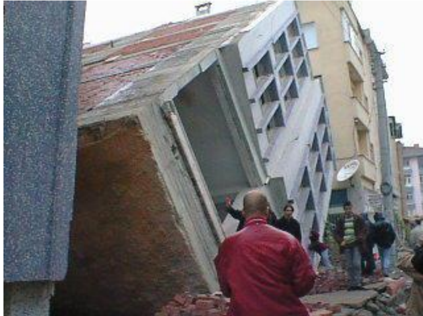
Şekil 2.4 : Kocaeli depreminde zemin sıvılaşması
