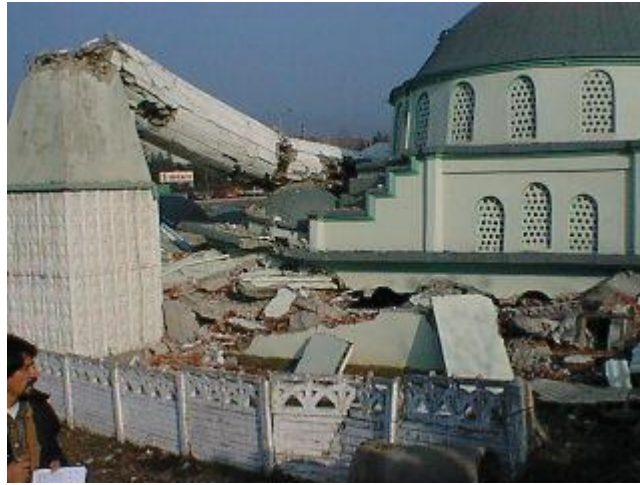
Şekil 2.12 : Düzce depreminde hasar gören bir cami ve minaresi
