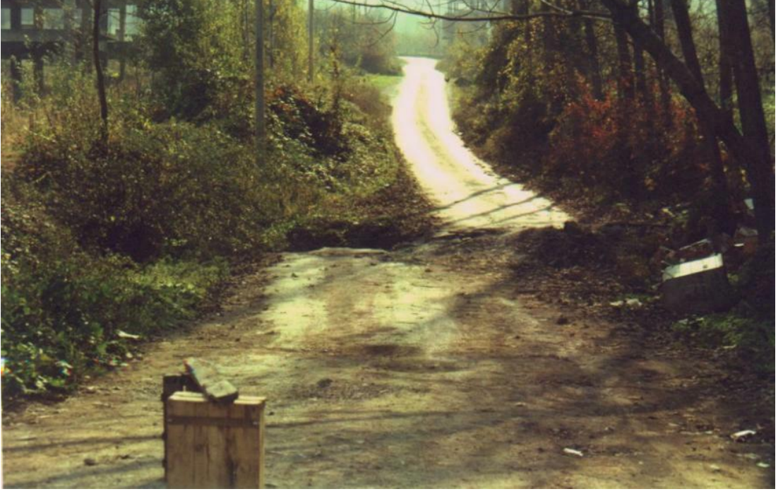
Şekil 2.11 : Düzce depreminin bir yolda oluşturduğu yanal atım
