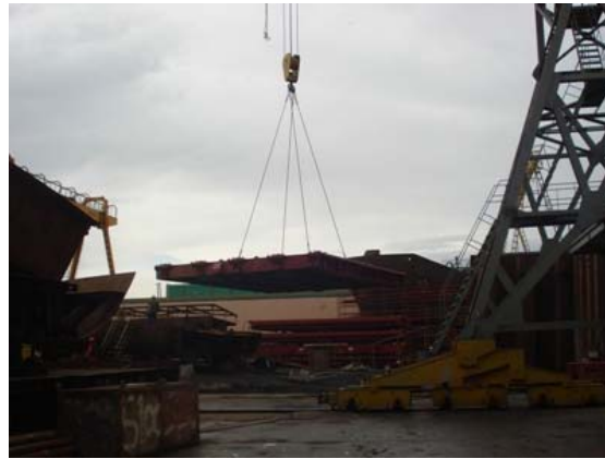
Şekil 3.4 : Güverte panel montajı.
