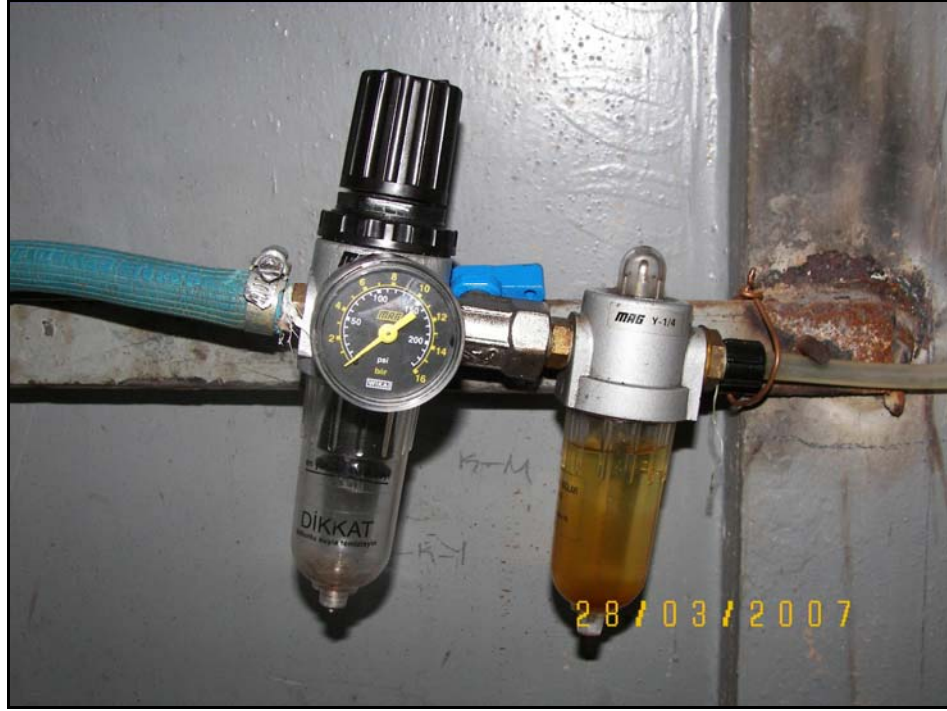
Şekil 3.2: Hava hazırlayıcı (şartlandırıcı)
