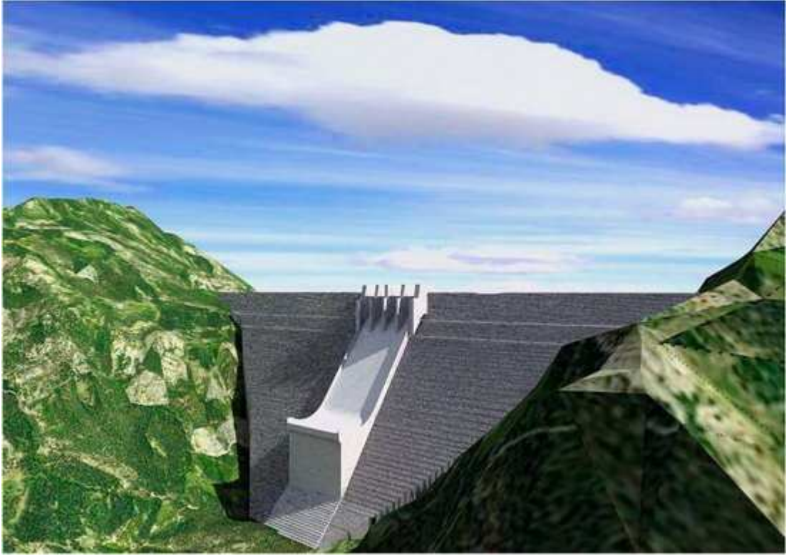
Şekil 1.2 : Ayvalı Barajı simülasyonu
