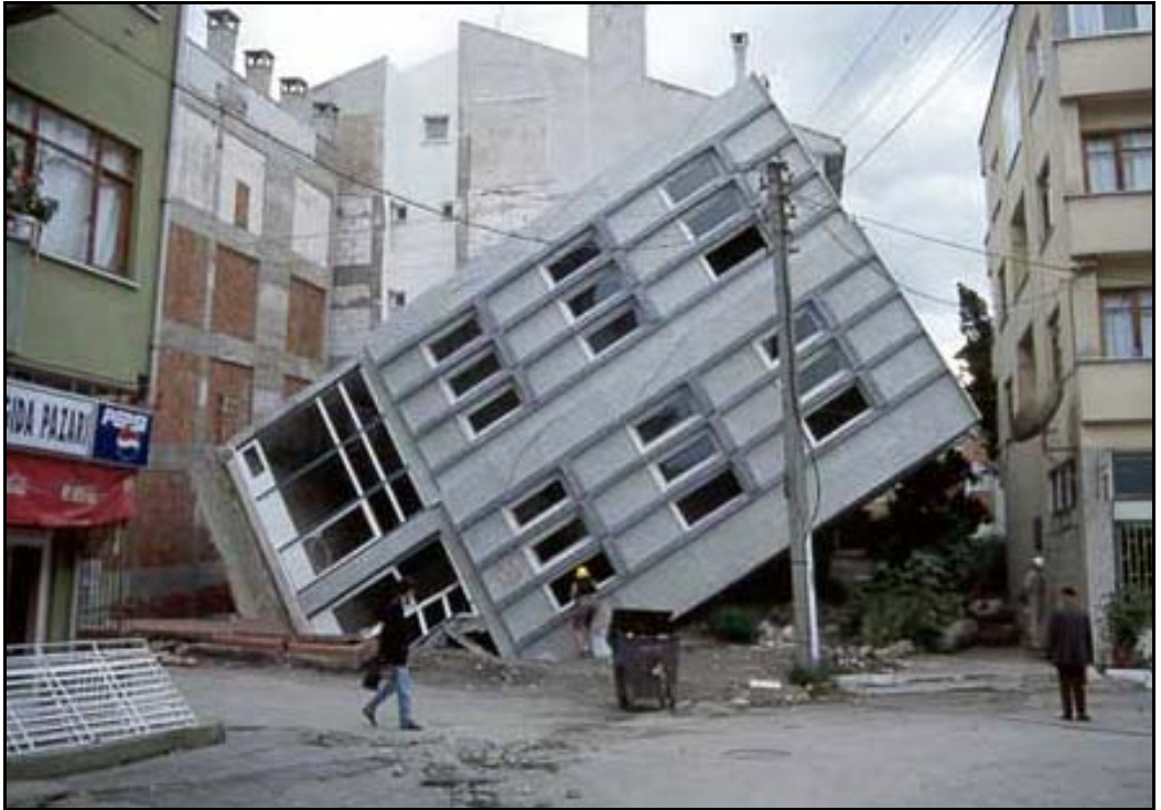
Şekil 4.20: Adapazarı’nda zemin sıvılaşması nedeniyle geriye yatmış bir bina, ( www.learn-hazards.org )
