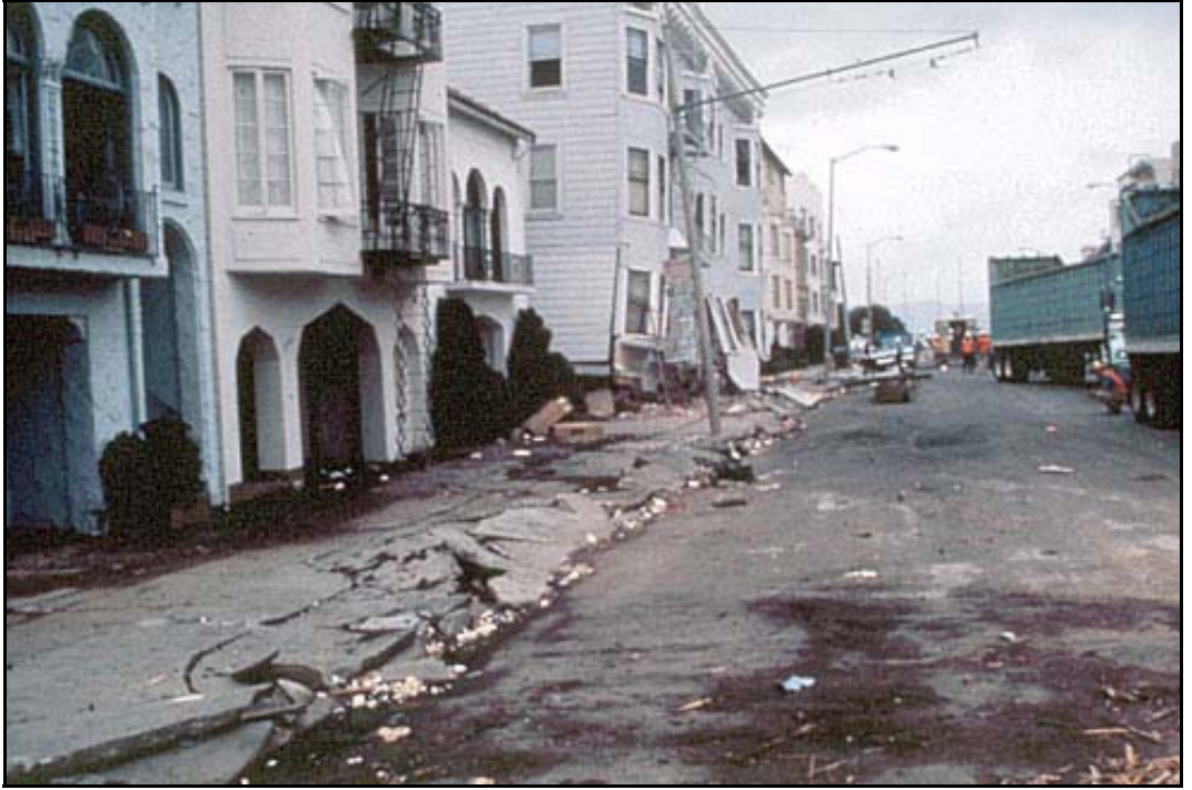
Şekil 4.19: San Francisco’da 1989 Depreminden Sonra Sahil Şeridinde Zemin Sıvılaşmasından Kaynaklanan Hasarlar ( www.pubs.usgs.gov )
