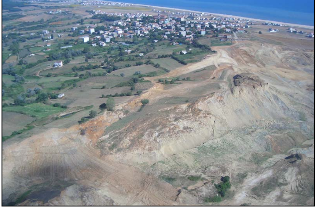
Şekil 5.3: Yeniköy Maden Ocaklarında İşletilme Sonrasında Oluşmuş Heyelan Türü Stabilité Bozulmaları
