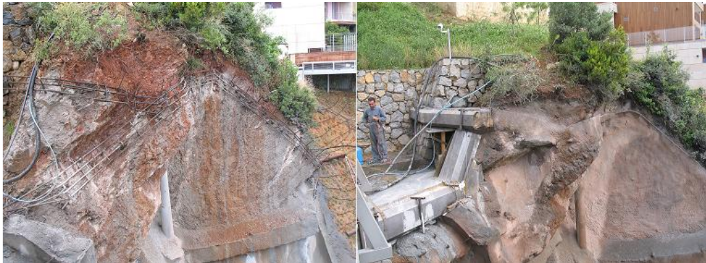
Şekil 4.22: Toprak örtüsünün hemen altındaki tutucu balkon yapısı
