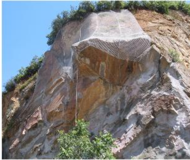
Şekil 4.28: Askıdaki blok üzerinde yapılan tel kafes uygulaması
