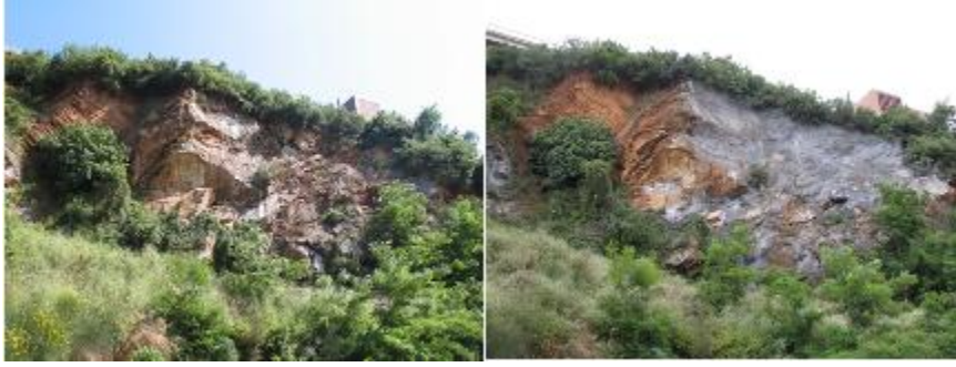
Şekil 4.36: Şev yüzeyinin uygulama öncesi ve uygulama sonrası genel görünümü
