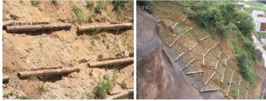
Şekil 4.14: Tomruklar ve arkalarına yerleştirilen tahta kazıklar
