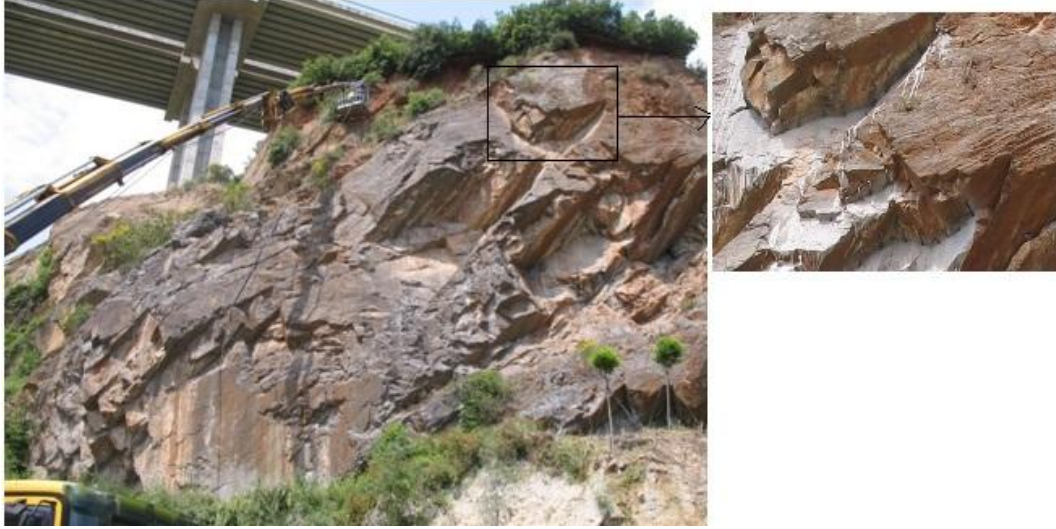
Şekil 7.35: 7.Bölgedeki kritik bloklar ve tabaka kaymalarına bağlı gelişerek ilerleyen (prograsif) sökûlmeleri durdurmak için alınan önlemler
