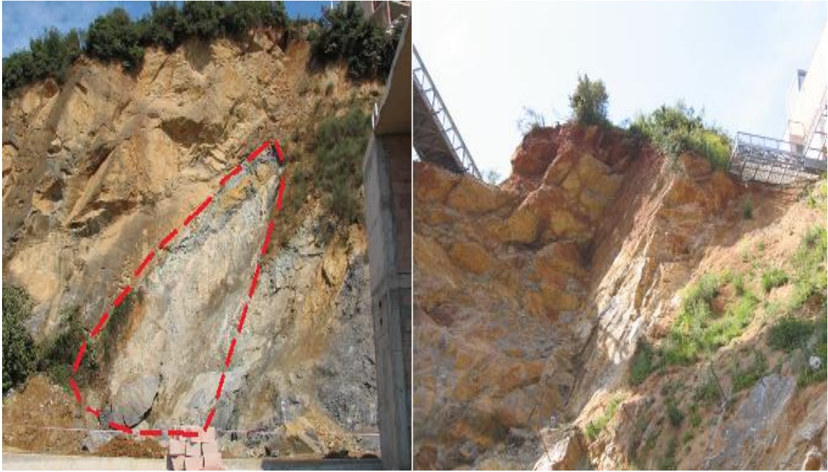
řekil 4.2: Asans r temelinin arkasında kalan 30 m y ksekliđindeki dik aynanın kaymadan  nceki ve kaydktan sonraki g r n m 
