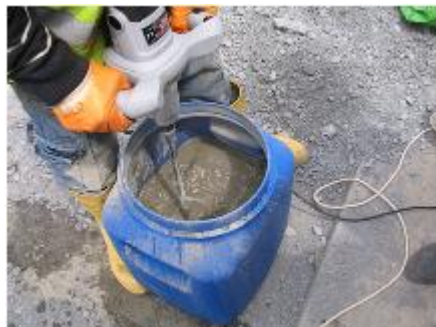
Şekil 4.7: Harcın karıştırılması
