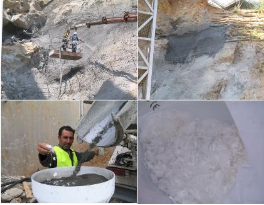
Şekil F.1: Püskürtme beton uygulaması ve elyaf kullanımına ait örnek resimler
