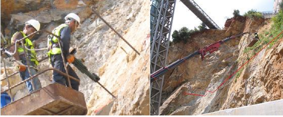
Şekil 4.4: Kaya civatalarının platform için yerleştirilme aşaması ve bitmiş hali
