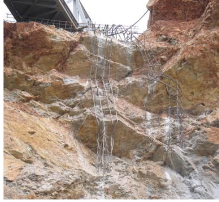
Şekil 4.19: Arazi geometrisine uygun, merdiven şeklindeki destek kolonları.
