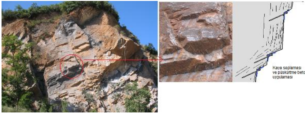
Şekil 4.26: Kaya civataları ile desteklenen kaya bloğu
