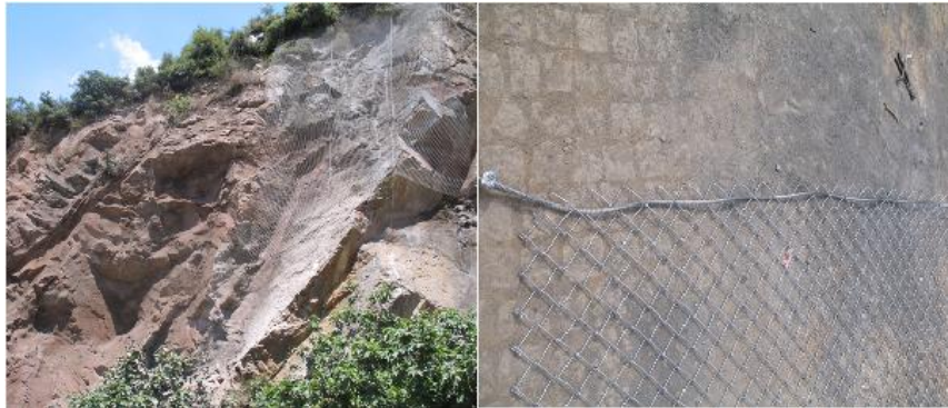
Şekil 4.16: Tel kafes uygulaması
