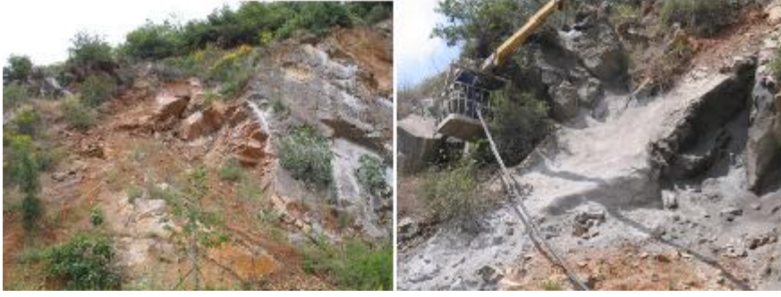
Şekil 4.30: Püskürtme beton yapılmadan ve yapıldıktan sonraki görünüm
