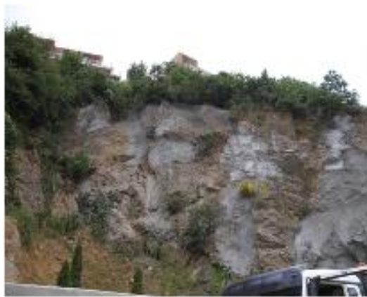
Şekil 4.34: Püskürtme beton uygulaması sonrasındaki şev görünümü
