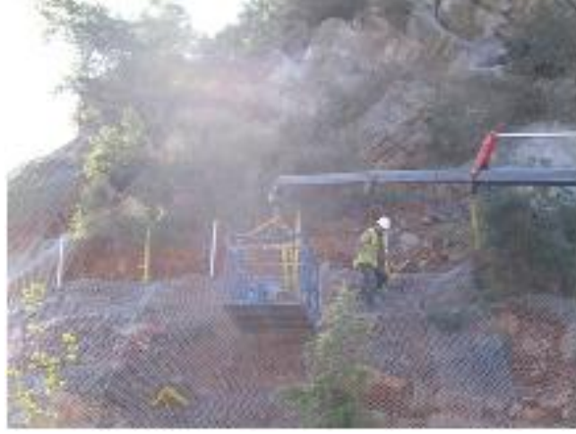
Şekil 4.32: Tel kafes uygulamasının bitmiş hali
