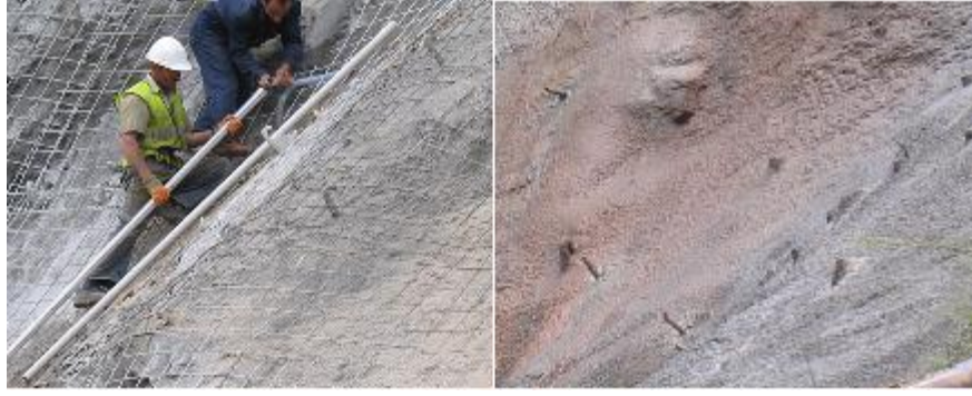
Şekil 4.24: Yeraltı suyunun uzaklaştırılması
