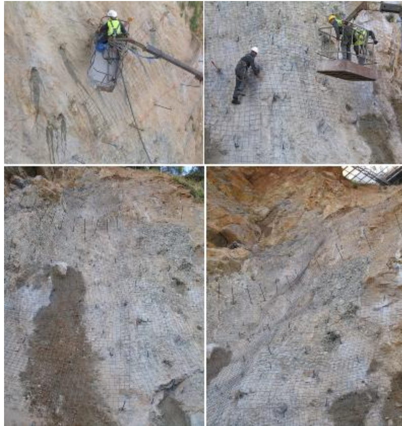
Şekil E.1: Çelik Hasır Uygulaması esnasında, şev yüzeyindeki çalışmalar
