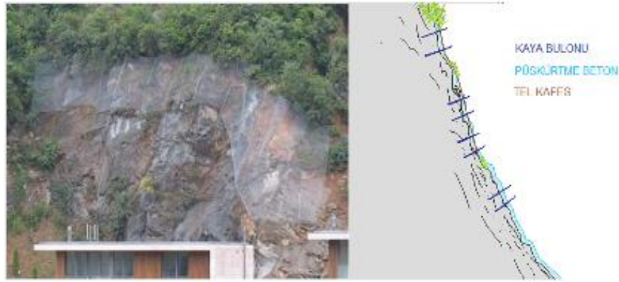
Şekil 4.35: Son uygulama olan tel kafeslerin şev yüzeyindeki görünümü
