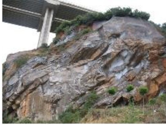
Şekil 4.39: Uygulamalar sonrasında şev yüzeyinin görünümü
