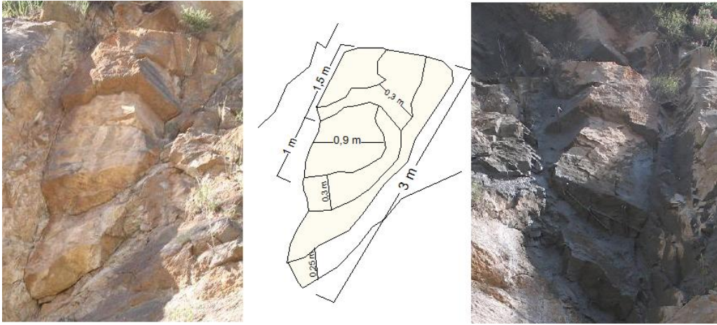
Şekil 7.7: 1 No'lu blok geometrisi ve işlem öncesi ve sonrasındaki görünüşü
