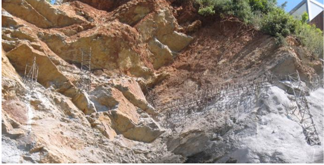
Şekil 4.18: İmal edilen kafes donatılar (Kolonlar ve kirişler)
