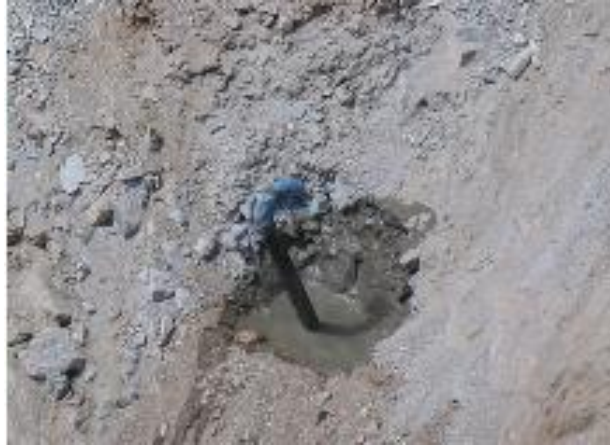
Şekil 4.5: Maviye boyanan 75cm Ø26 nervürlü bulon
