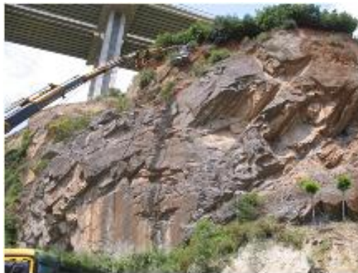
Şekil 4.38: Uygulama öncesi şev yüzeyinin görünümü
