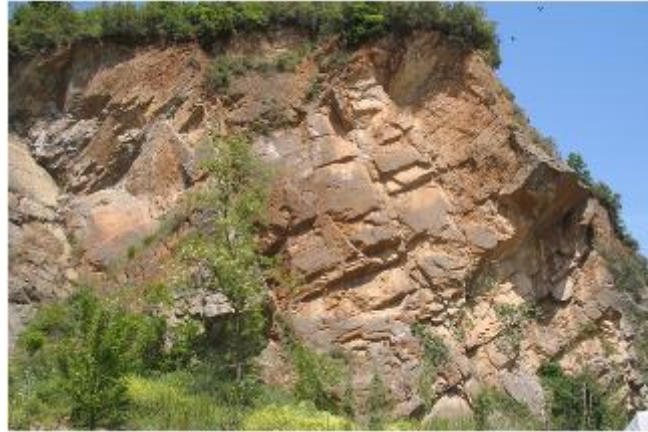
Şekil 4.25: 2. Bölgenin uygulama öncesi görünümü
