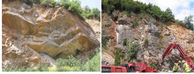
Şekil 4.29: Bölge şev yüzeylerinin genel görünümü
