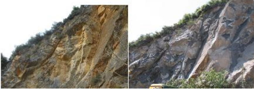
Şekil 4.15: Püskürtme betonun sadece işlem yapılan bölgelere uygulanması
