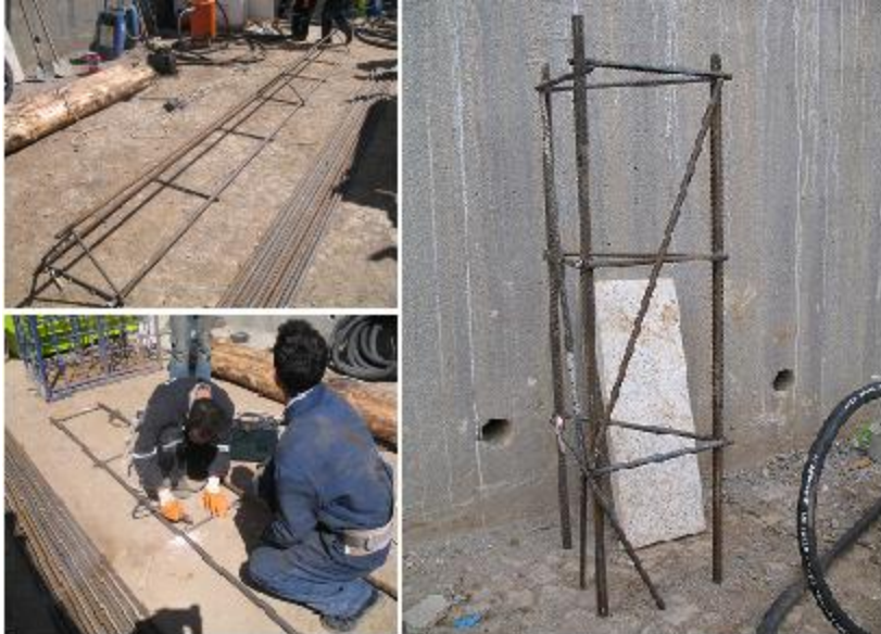
Şekil G.1: Kolon ve kirişlerin yapım aşamasından bazı örnek resimler
