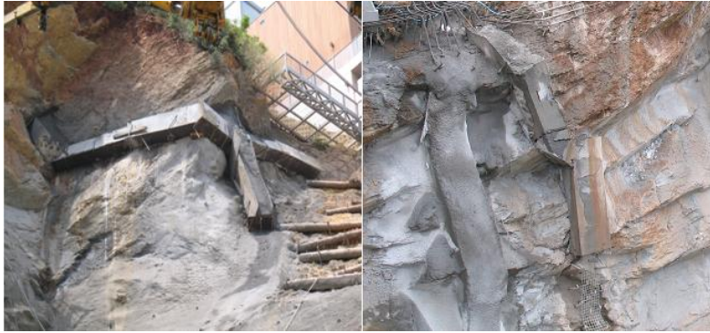
Şekil 4.20: Dış kalıpların hazırlanması ve sökülmesi
