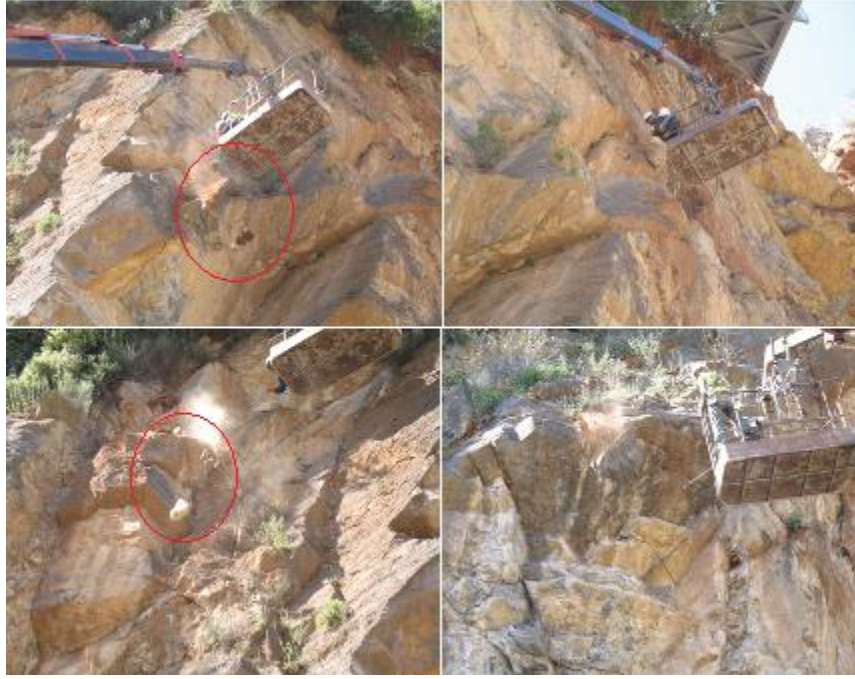
Şekil D.1: Kavlak düşürme uygulamalarına birkaç örnek
