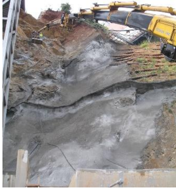
Şekil 4.11: Asansör arkası püskürtme beton uygulaması
