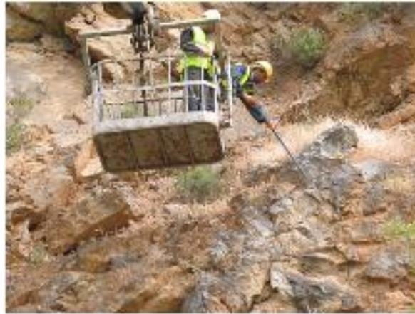
Şekil 4.37: Kavlak düşürme uygulamasından bir görünüm
