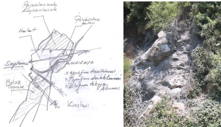
Şekil 7.34: Blok için öngörülen çalışmalar(sol), ve uygulama sonrası durumu(sağ)
