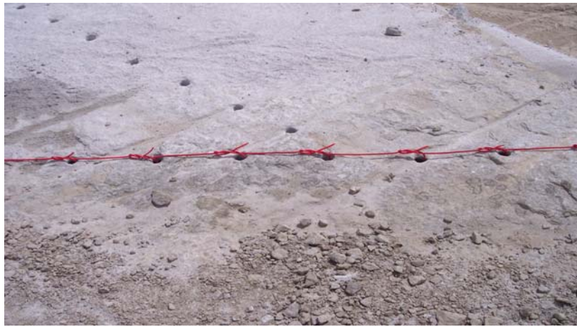
Şekil 3.12: Açılan deliklerin içine yerleştirilen patlayıcı fitiller.
