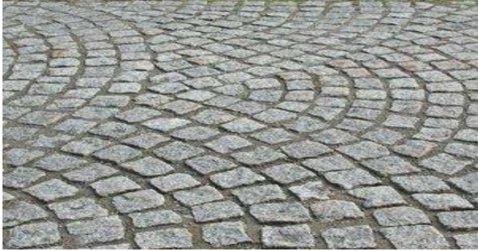
Şekil 4.7: Sert taşların zar parke taşı olarak yol döşemesinde kullanımı.
