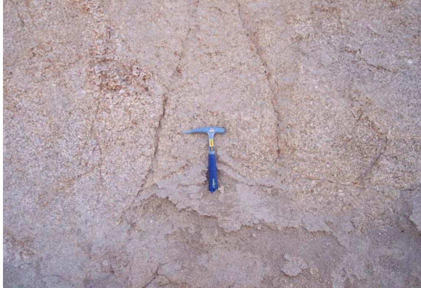
Şekil 3.15: Aksaray Yaylak granit ocağının üst kesimlerinde görülen arenalaşma.
