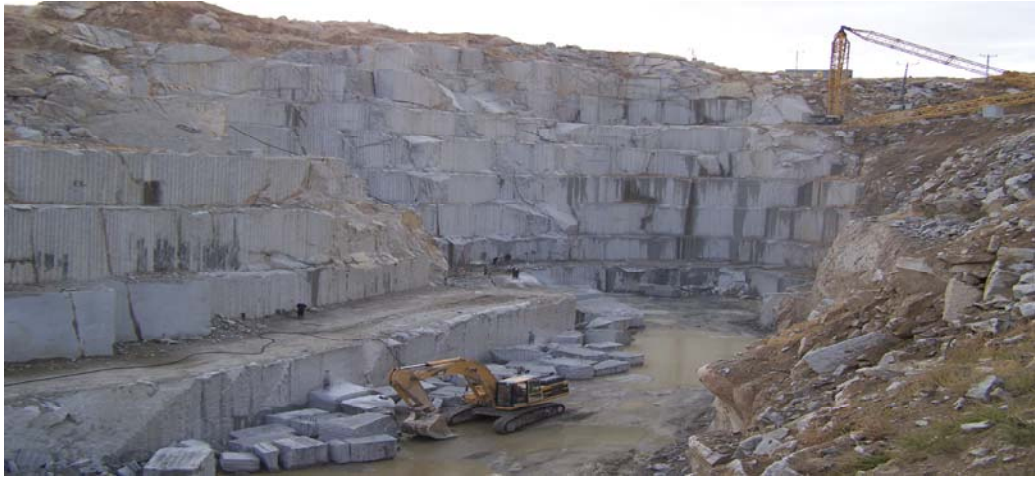
Şekil 3.9: Açık çukur işletme tipindeki Aksaray Yaylak blok taş ocağının genel görünümü.
