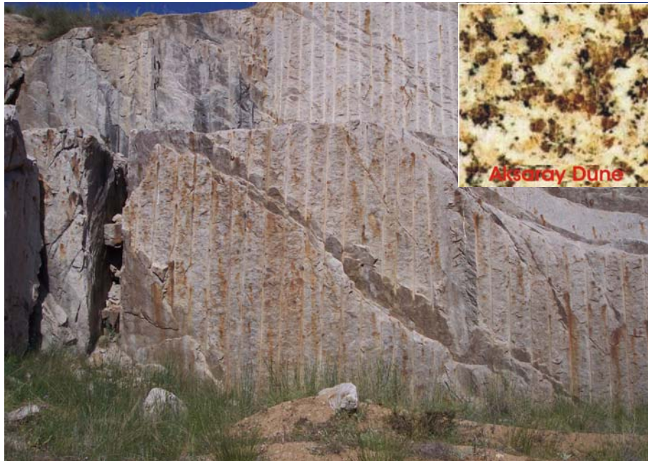
Şekil 3.5: Aksaray Düne granit ocağında görülen pas lekeleri.
