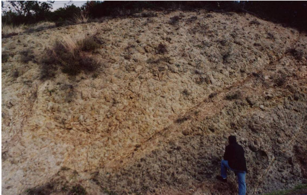
Şekil 2.3: Kabakoz köyü batısında izlenen blok-çamur akıntılarının genel görünümü
