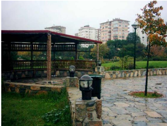
Şekil 5.9: Kafeterya çevresinde yer alan pergolaların aydınlatmasında kullanılan aygıt örneği
