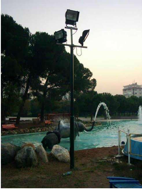
Şekil 5.24 : Direk üstüne monte edilmiş projektör aygıtı örneği
