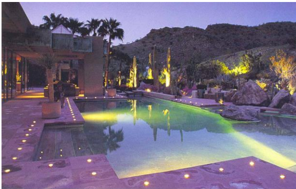
Şekil 4.22: Havuz çevresinde ve içinde yapılan aydınlatma sistemi örneği [22]
