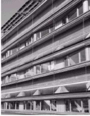
Şekil 3-24: LESO deney amaçlı binasının yenilenmiş cephesinden bir görünüş [3].
