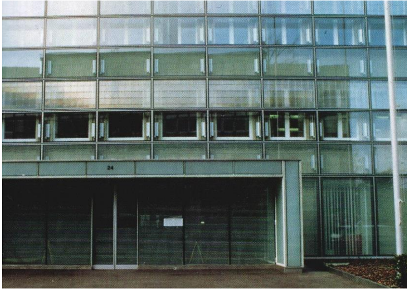
Şekil 3-35: CNA-SUVA binasının giydirme cephesinin dışarıdan görünüşü [2].
