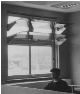
Şekil 3-11: Yansıtıcı camdan yapılmış iki kademeli yarı saydam yüzeye sahip iç ışık rafı [3].
