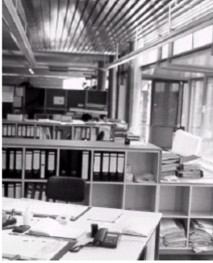
Şekil 4-54: Cologne'deki Geyssel Ofis Binası'nda bulunan, üst kısmında ışık yönlendirici cam uygulanan pencereleri olan ofisin içeriden görünüşü [3].
