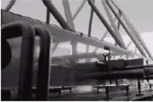
Şekil 3-55: Rewe Merkezi’ndeki holografik saydam gölgeleme sisteminin hareketli elemanlarının dışarıdan görünüşü [3].
