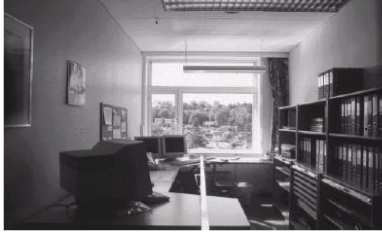
Şekil 4-41: Pencerenin üst kısmına yerleştirilen ir LKP'nin içeriden görünüşü [3].
