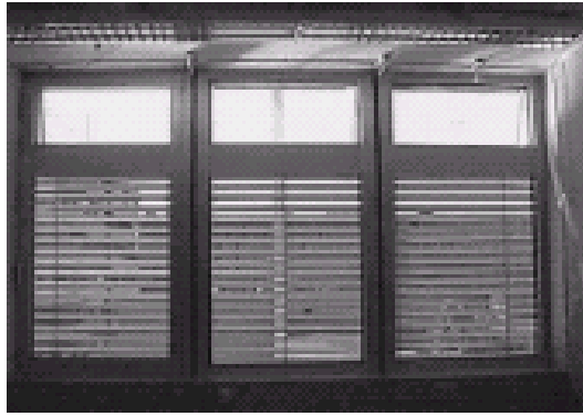
Şekil 4-46: Test odasının penceresinin alttaki üçte ikilik bölümünün dış güneşlikle kapatıldığı zamanki içten görünüşü [3].
