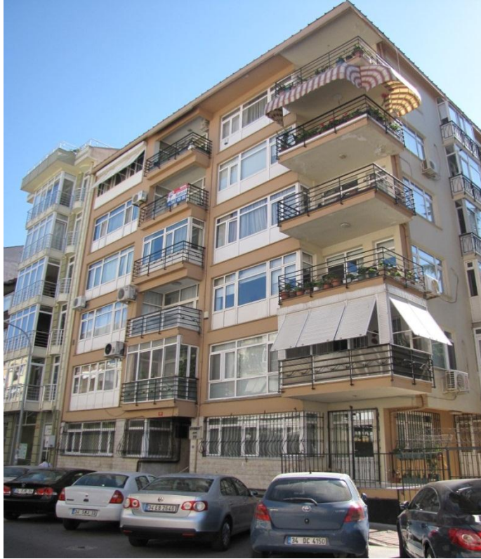
Şekil 4.3 : Alan cephe görünüşü.
