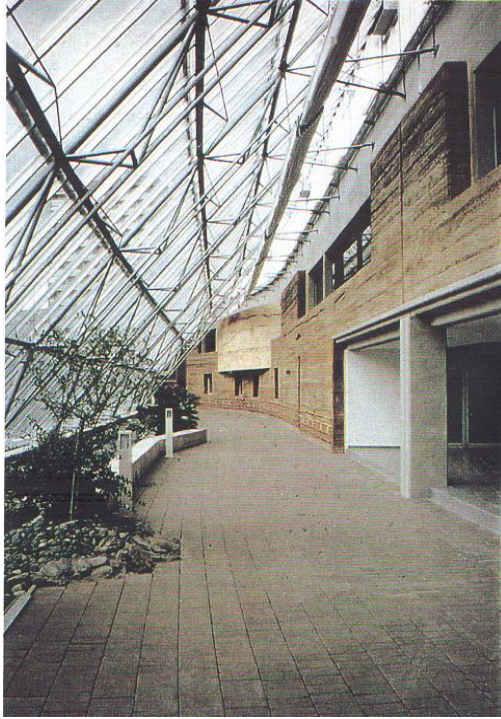
Şekil 4.1: Üstte: Fransa' da Lyon yakınlarında Arse kilisesi; Avustralya, Feldkirch' te tokmaktama yöntemiyle yapılmış eğri toprak duvar. Altta: Devon Tricombe' de yapım aşamasındaki kır evi; Devon' da yeni bir toprak yapı, Attricombe kır evi [31].
