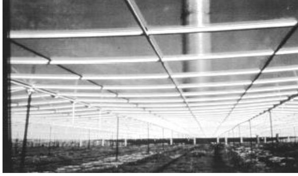
Şekil 3.31 Güneş bacasının cam kollektör çatısı. (Schlaich, 1999)
