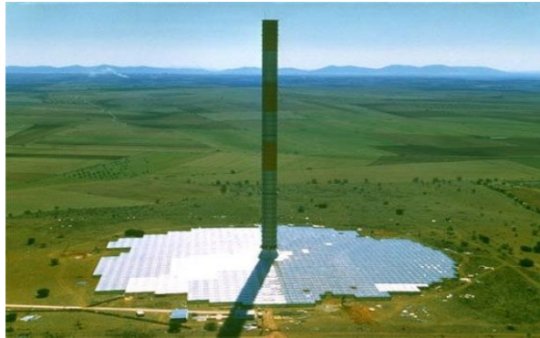
Şekil 3.30 Manzanares / İspanya'daki güneş bacası. (Schlaich, 1999)
