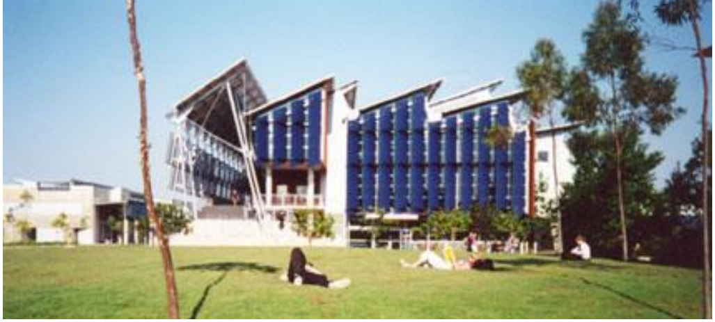
Şekil F.1 Batı cephesi.
