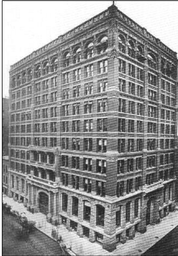
Şekil 2.2 - Home Insurance Binası, Chicago
