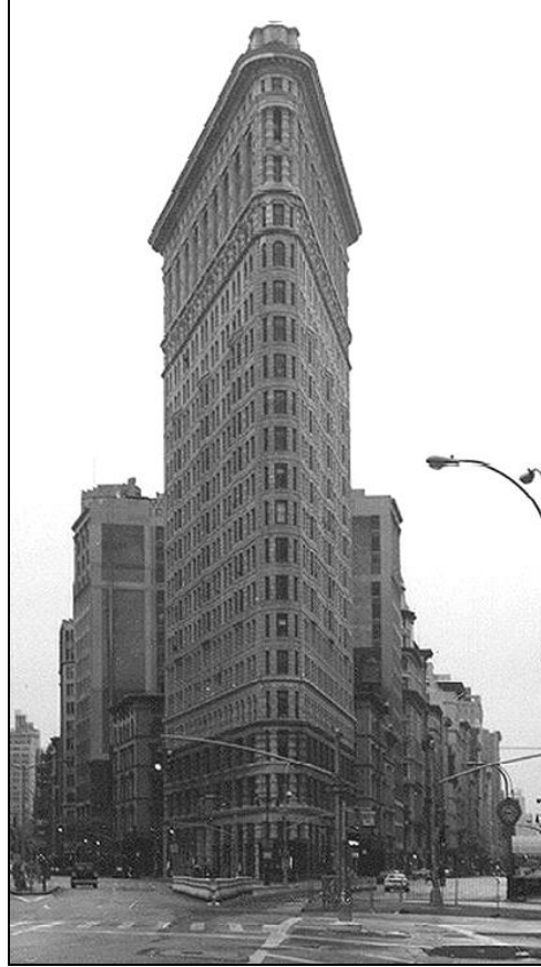
Şekil 2.4 - Flatiron (Fuller) Binası, New York
