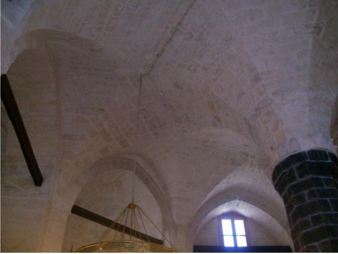
Şekil B.10: Şeyh Fethullah Cami, sekizgen sütun ve yelpaze tonoz çatı örtüsü, Gaziantep (Sevim, 2012).
