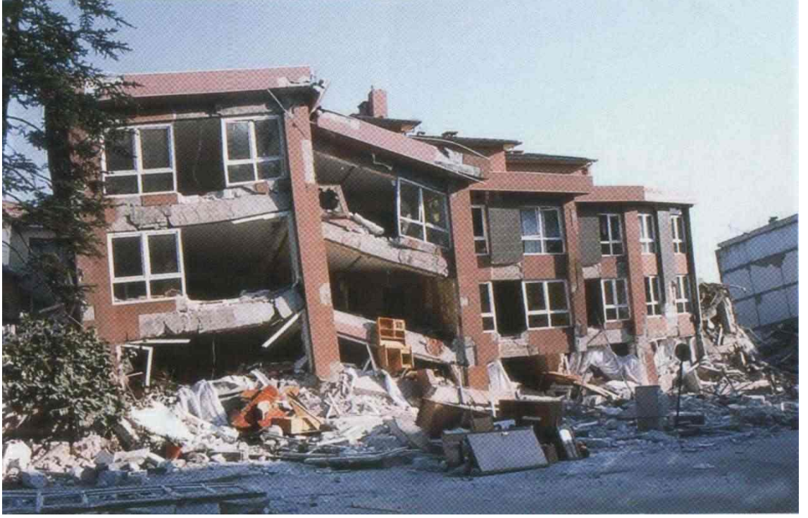
Şekil 3.6 Taşıyıcı sistem aksları birbirine paralel olmayan bir bina [23].
