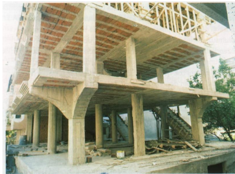
Şekil 3.14 Konsol ucunda kolonlu bir bina [18].
