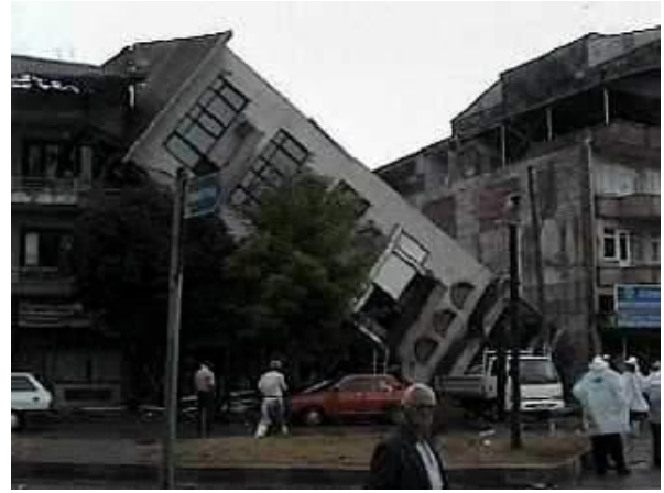
Şekil 2.16 Zemin sıvılaşması sonucu binalarda oluşan hasarlar[24].
