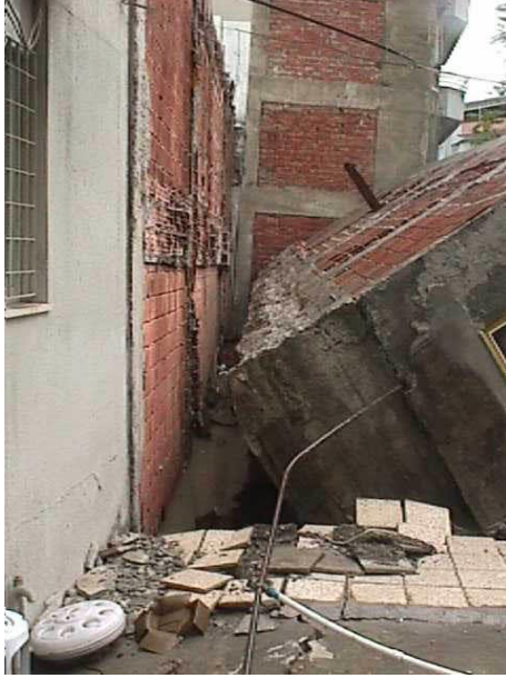
Şekil 2.16 Zemin sıvılaşması sonucu binalarda oluşan hasarlar[24].
