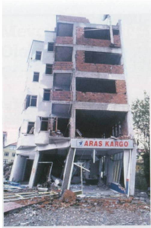
Şekil 3.10 Betonarme bir binada yumuşak kat oluşumu (Adapazarı) [18].
