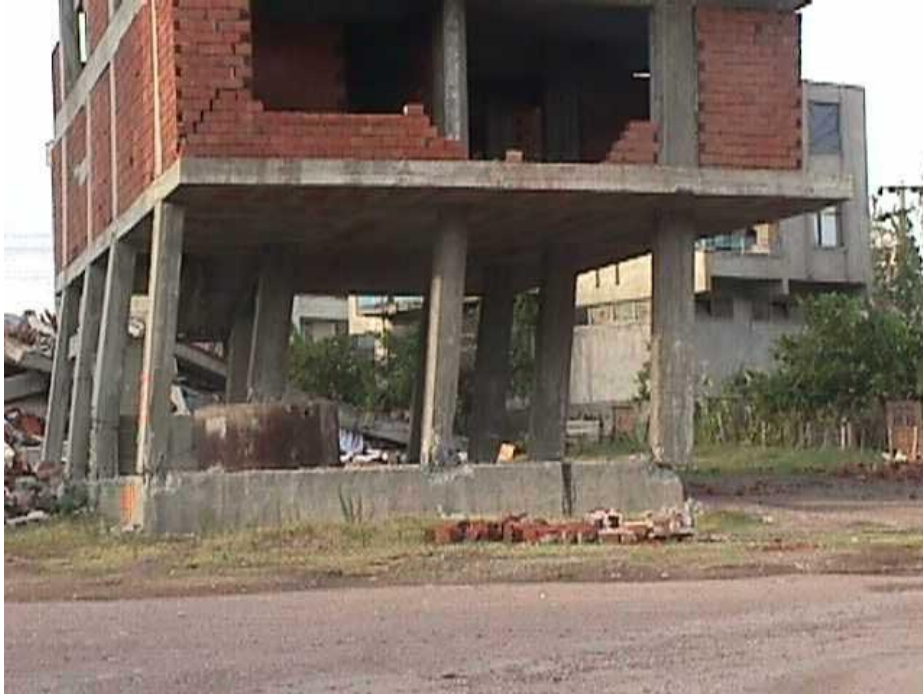
Şekil 2.15 Zemin katta yumuşak kat oluşumu [24]
