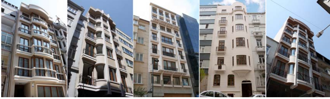
Şekil 4.10: İstanbul Nişantaşı'nda faaliyet gösteren bir inşaat firmasının uygulamalarından örnekler (Url-8).
