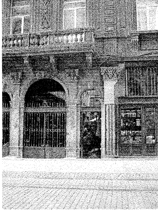
Şekil 4.9 Tünel Meydanından arka sokaklara geçit veren kapı – Tünel Geçiti
