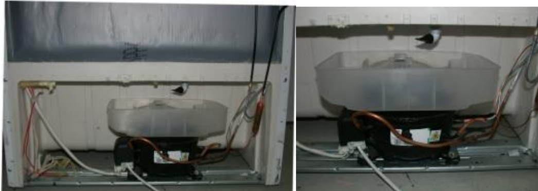
Şekil 2.121: NM4 kompresör bölgesinin görünüşü.
