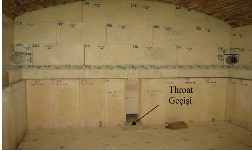
Şekil 1.12 : Cam Fırını Refrakter Yapısı ve Throat Geçişi
