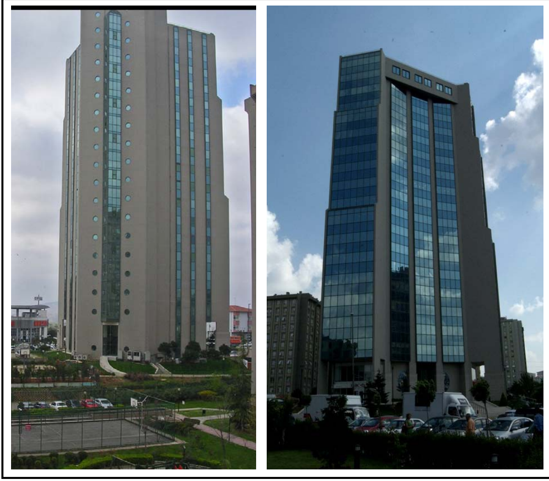
Şekil 5.1: Ataşehir binasının kuzey ve güney cephesi fotoğrafları.
