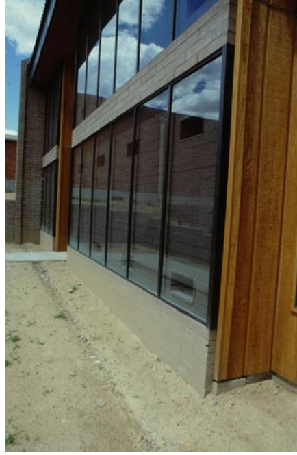
Şekil 5.5 : Trombe duvarı görünüşü.
